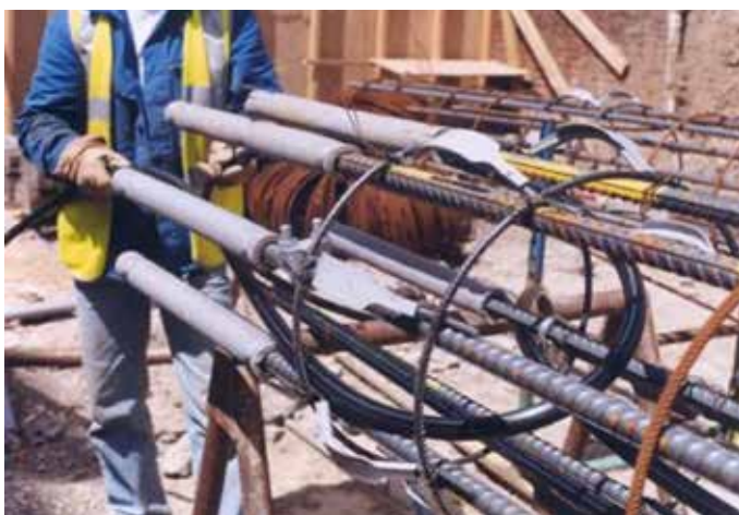
Figura 3.53 Ejecución de pilotes geotérmicos. Fuente: Eneres.
