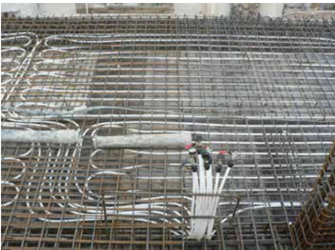
Figura 3.48 Forjados termoactivos. Fuente: Eneres.
