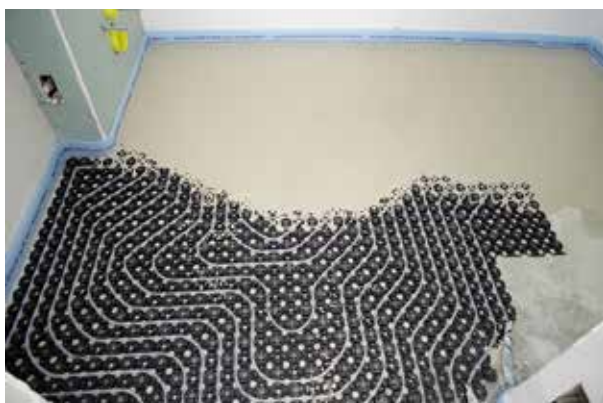
Figura 6.30. Juntas de dilatación.
