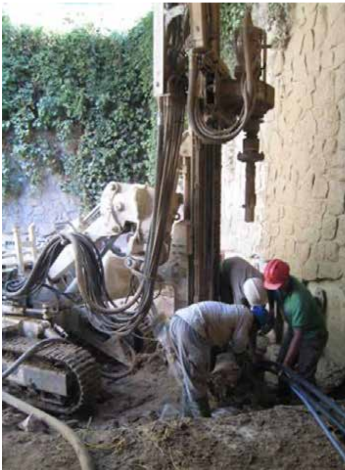
Figura 3.50 Perforación de pozos geotérmicos. Fuente: Eneres.
