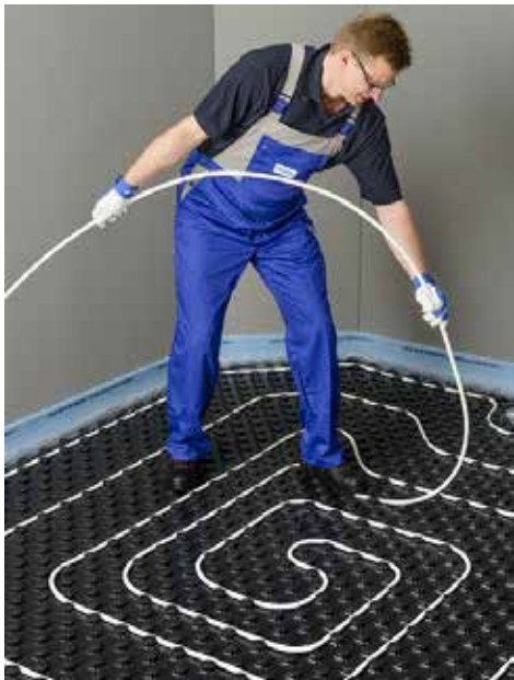
Figura 6.31. Instalación de tuberías plásticas de polietileno reticulado.
