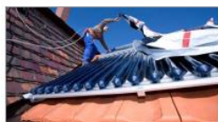
Figura 62. Ejemplo instalación tubos de vacío
