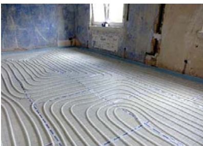
Refrigeración y calefacción radiantes
