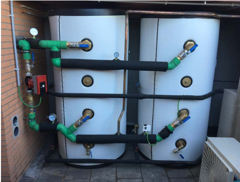
Instalación de ACS con caldera mural y kit solar
