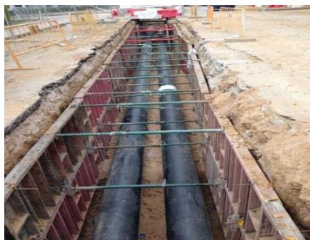
Realizada en tubería de acero preaislada, y enterrada a una profundidad de entre 2 y 3 metros, dotada de sistema de detección de fugas.
