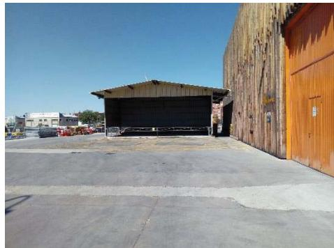
Silo de 300 m<sup>3</sup> con 3 zonas de descarga, una cubierta y dos mediante trampilla a nivel del suelo. Suelo móvil y redlers de alimentación a calderas
