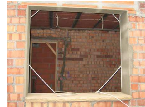
Edificio de Obra nueva. Ventana con premarco
