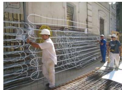
Pilotes y solera termoactiva: rehabilitación palacete Protegido, Madrid 2009-2011
