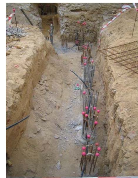
Pilotes y solera termoactiva: rehabilitación palacete Protegido, Madrid 2009-2011
