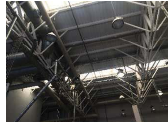
Separación laboratorios, ventanales, conductos,etc
