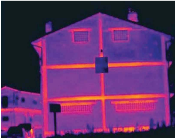
Termografía fachada Nov-2018
