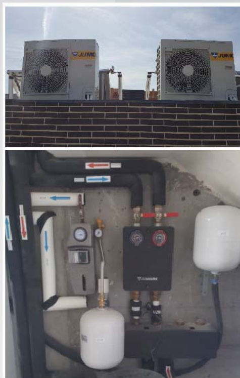
Bombas de Calor Multitarea. Viviendas pareadas Leganés. Calefacción, Refrescamiento y A.C.S. y sistema solar
