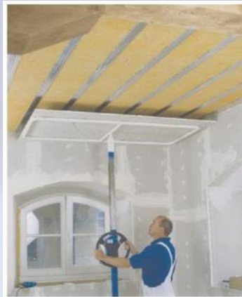
Techo Knauf D11 + Lana mineral
