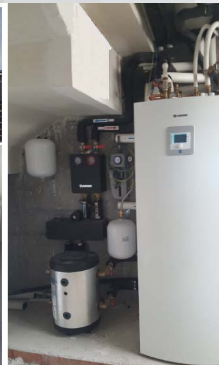
Bombas de Calor Multitarea. Viviendas pareadas Leganés. Calefacción, Refrescamiento y A.C.S. y sistema solar
