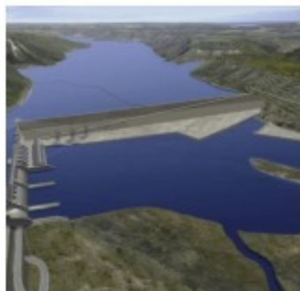
Presa Site C, Canadá
