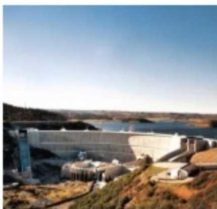
Presa de Alqueva, Portugal
