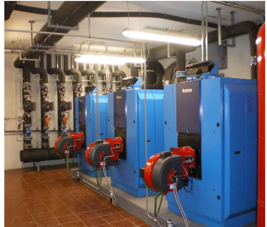
**Calderas de gas o gasóleo de condensación, con alta eficiencia energética y funcionamiento silencioso, y de alta fiabilidad operacional.**
