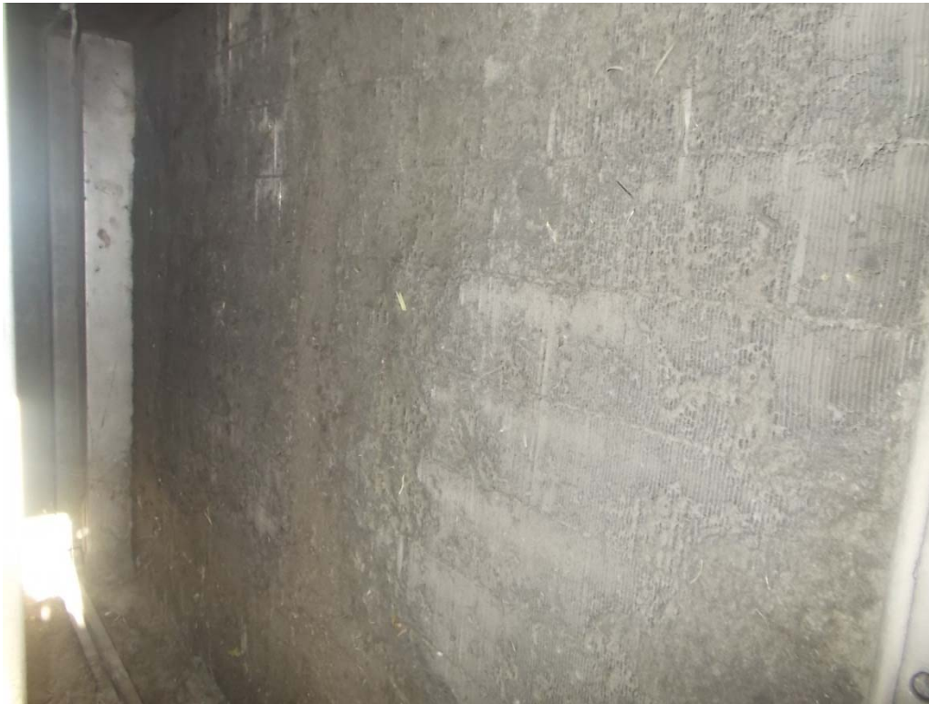
IMAGEN DE BATERIA DE FRIO CON ALTO NIVEL DE CONTAMINACION
