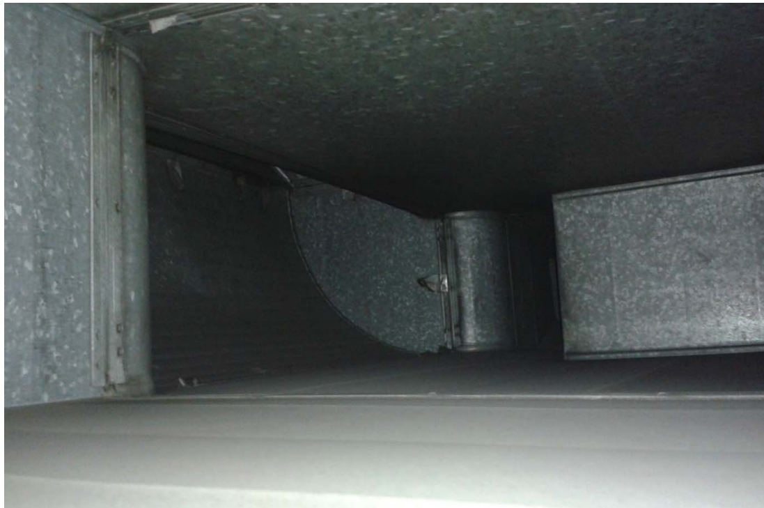
IMAGEN DE INTERIOR DE CONDUCTOS CON NIVEL DE CONTAMINACION NORMAL
