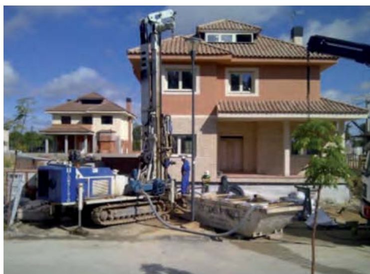
Foto 5.12. Geotermia en vivienda unifamiliar. Fuente: Girod Geotermia.
