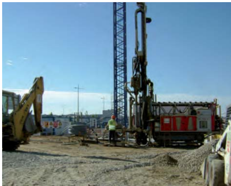
Foto 4.3. Ejecución de sondeo en instalación geotérmica. Fuente: Sacyr Industrial.
