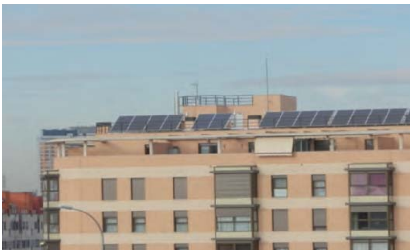
Foto 5.6. Instalación solar térmica.
