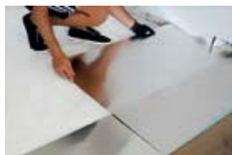
Colocación de los difusores térmicos
