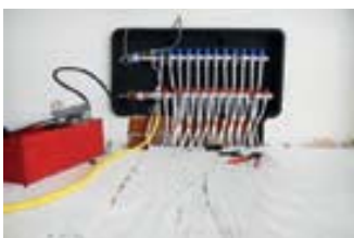
Conexión a colector y pruebas hidráulicas
