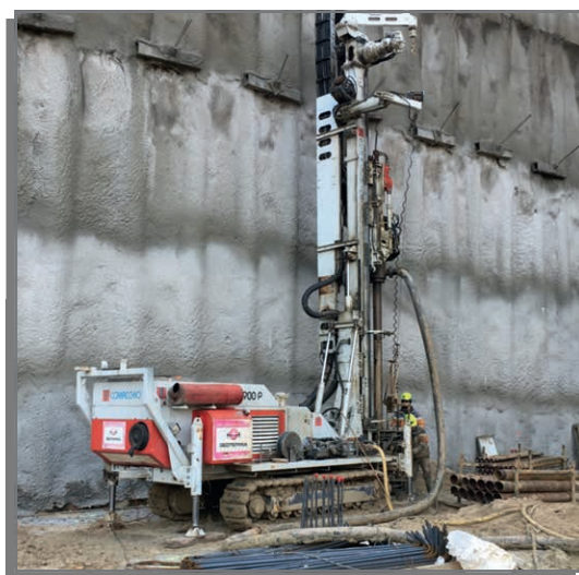
Ejecución de sondeos geotérmicos con equipo MC 900P.
