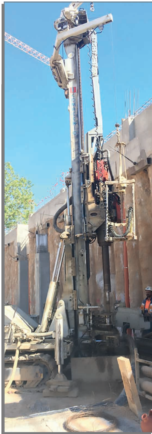
Ejecución de sondeos geotérmicos con equipo MC 900P en parcela Calanda Homes.
