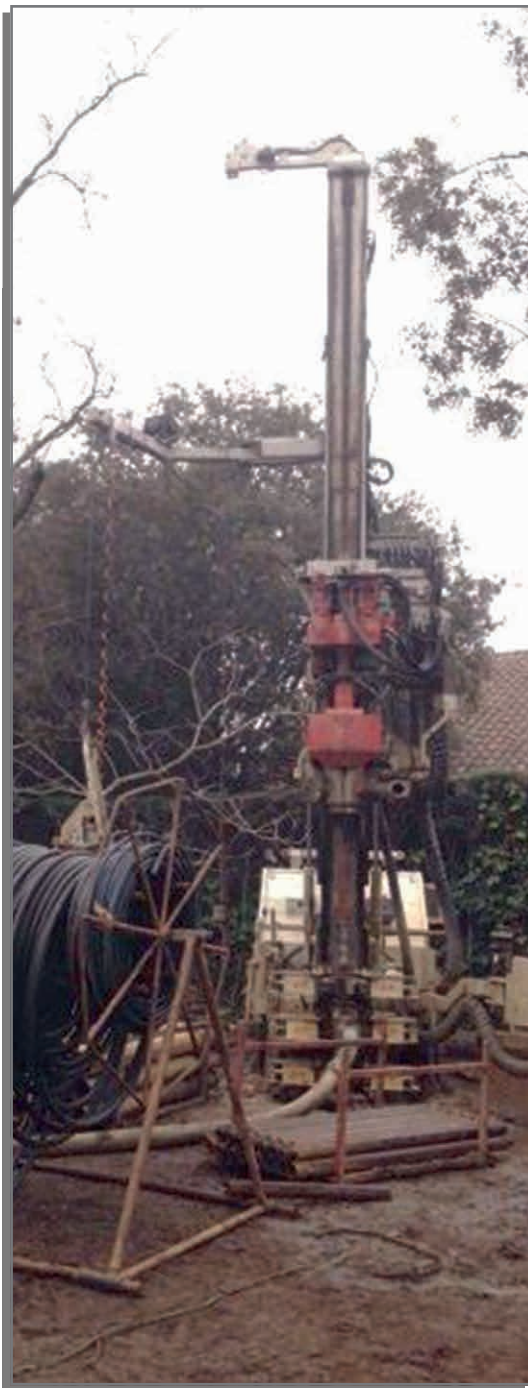
Perforaciones geotérmicas.
