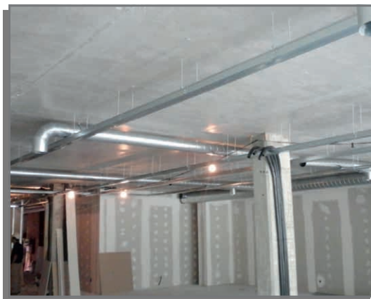
Instalación ventilación interior oficinas.
