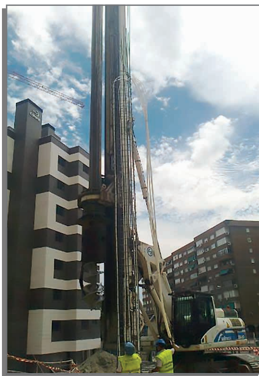
Termoactivación de pantalla de pilotes.
