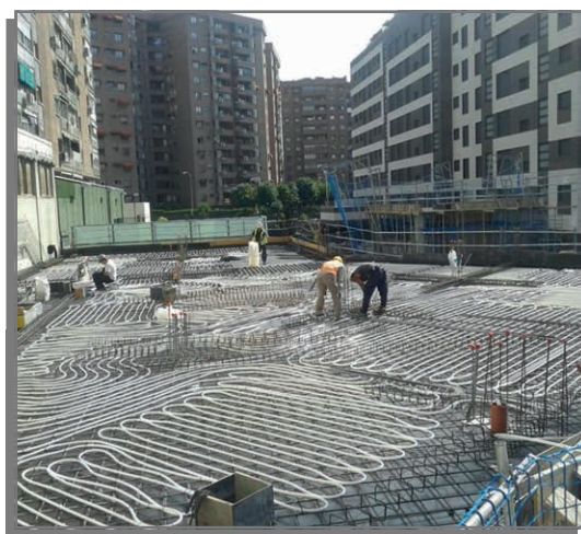
Ejecución de los forjados termoactivos de las plantas del edificio.
