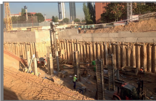
Ejecución de sondeos geotérmicos con equipo MC 900P en parcela Calanda Homes.
