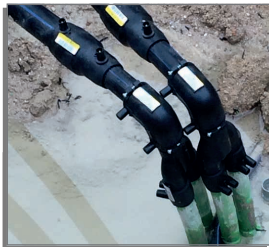
Detalle conexión trazado horizontal.
