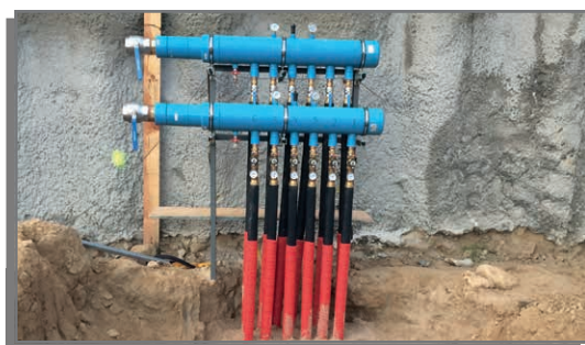
Conjunto de colectores unificadores 6 grupos de 5 sondeos.
