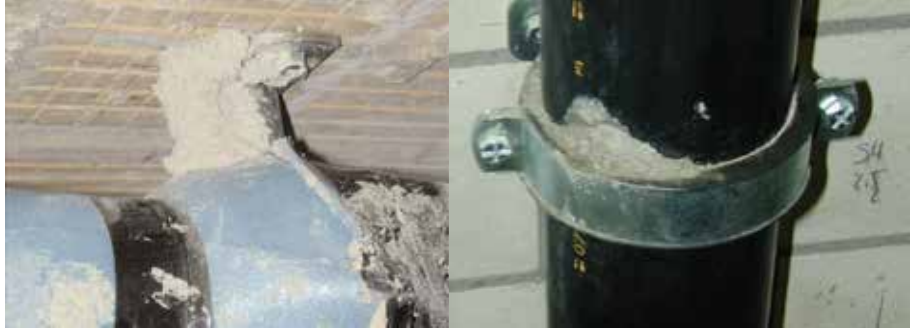
Figura 4.20: Abrazaderas isofónicas con restos de mortero. Fuente: Geberit.
