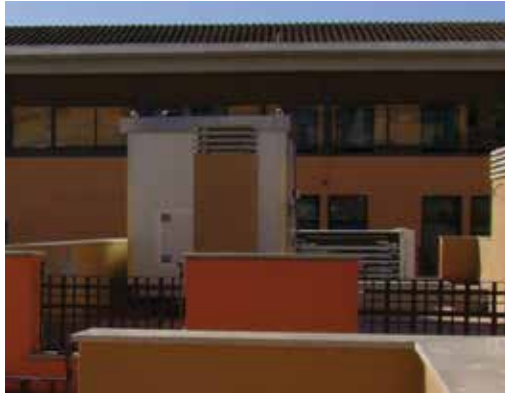
Figura 8.16. Equipo autónomo instalado en cubierta (izquierda) y con calderas murales (derecha). Fuente: Viessmann.
