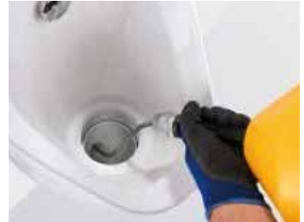
Figura 4.11. Limpieza de tubería de evacuación sin desmontar el urinario de la pared.
