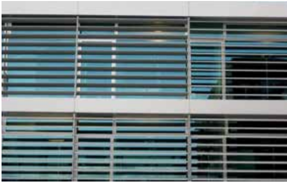
Figura 7.12. Protecciones solares exteriores. Fuente: Saint-Gobain Building Glass
