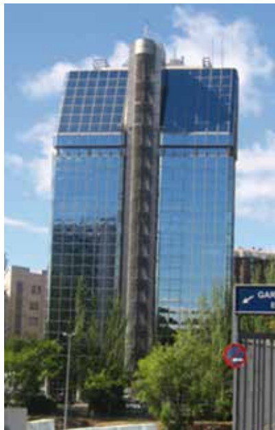
Figura 7.5. Fachada acristalada con vidrio de control solar reflectante. Fuente: Propiedad del autor.
