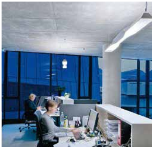
Figura 2.15. Sala con iluminación mixta de distribución simétrica. Natural y LED. Fuente: Grupo Lledó.
