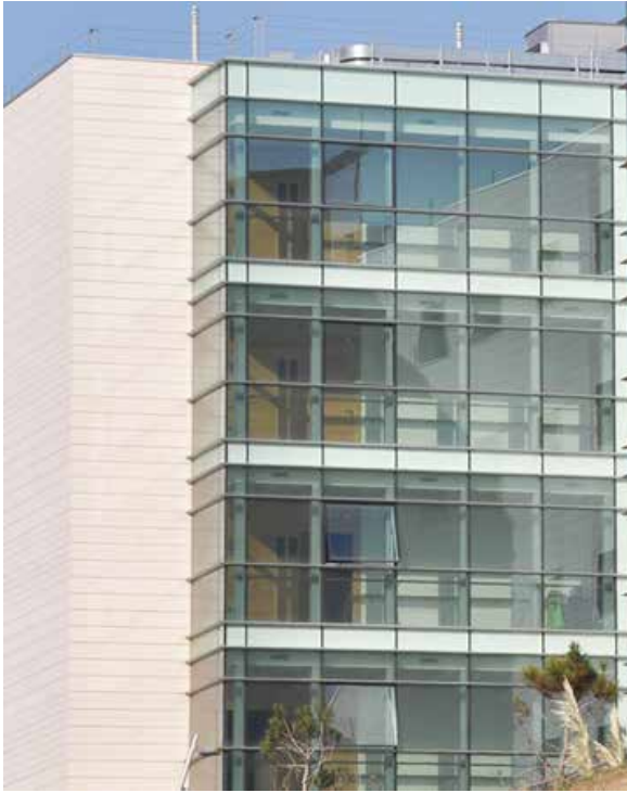
Foto 9.7. Fachada de residencial ejecutado con vidrio de control Solar de alta selectividad. Fuente: Saint-Gobain Building Glass.
