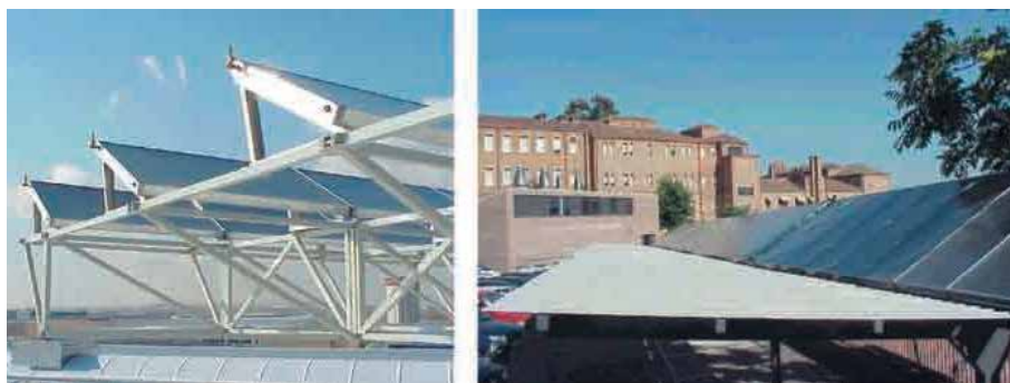
Foto 7.2. Posibilidades de montaje. Colectores planos.
