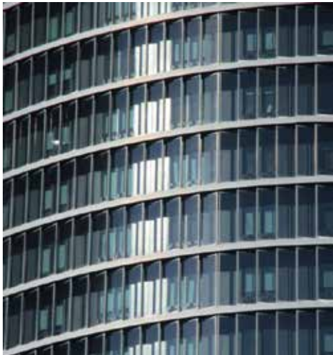
Foto 9.4. Fachada con lamas de protección solar en vidrio de color en masa gris.
