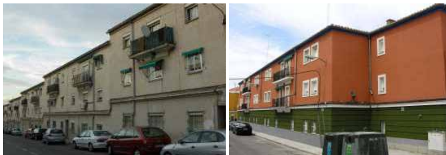
Figura 9.11. Apariencia estética de un edificio antes y después de la rehabilitación con un Sistema de Aislamiento Térmico por el Exterior, SATE.
