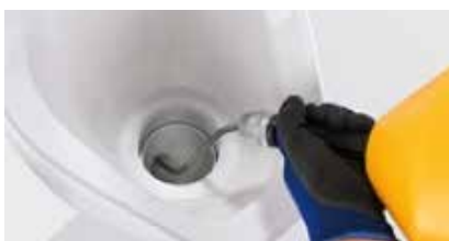
Figura 3.11. Limpieza de tubería de evacuación sin desmontar el urinario de la pared.
