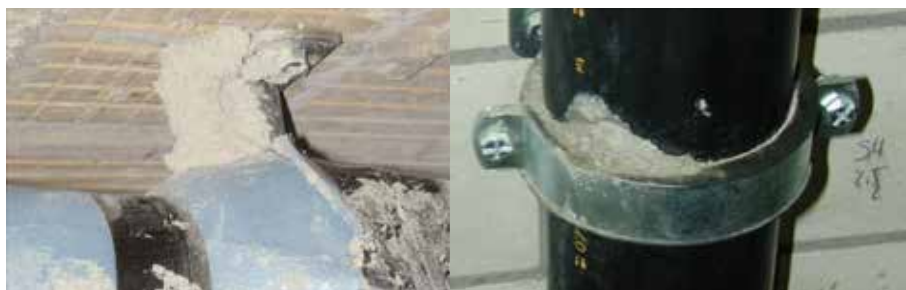
Figura 3.24. Abrazaderas isofónicas con restos de mortero. Fuente: Geberit.
