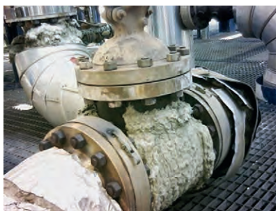
Figura 2.1. Instalación con Aislamiento Deteriorado y Zonas sin Aislar.
