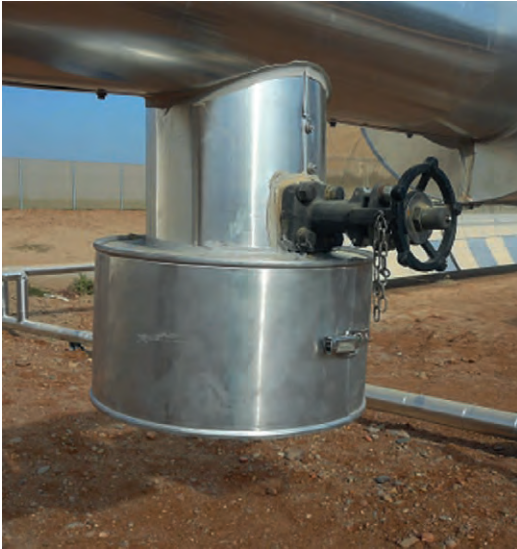
Figura 4.11.4. Ejemplo de ejecución de caja desmontable en bridas.
