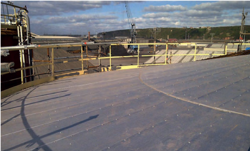
Figura 4.11.9. Ejemplo de aislamiento de techo.
