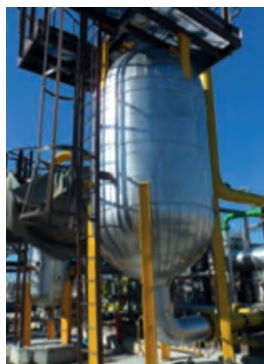
Figura 4.4.3.A. Ejemplo aislamiento en equipo vertical.
