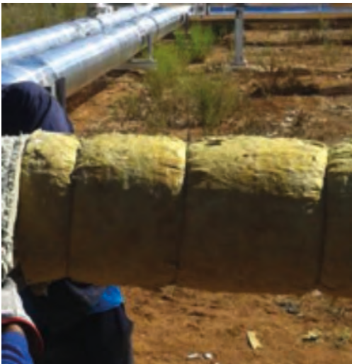
Figura 4.3.2.C. Ejemplo de atado de coquilla con alambre.
