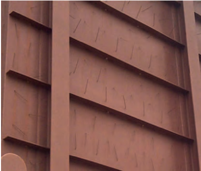
Figura 4.4.1.A. Ejemplo de colocación de pinchos y pernos.
