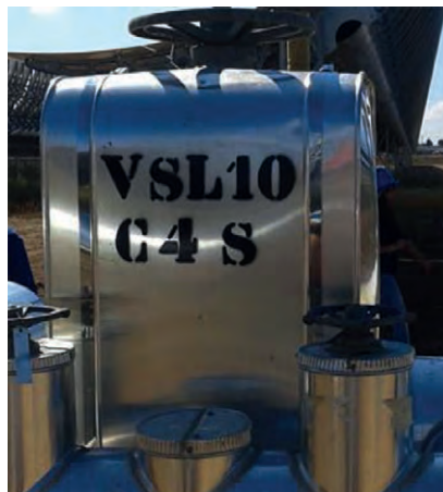
Figura 4.3.2.E. Ejemplo de cajeado metálico desmontable.
