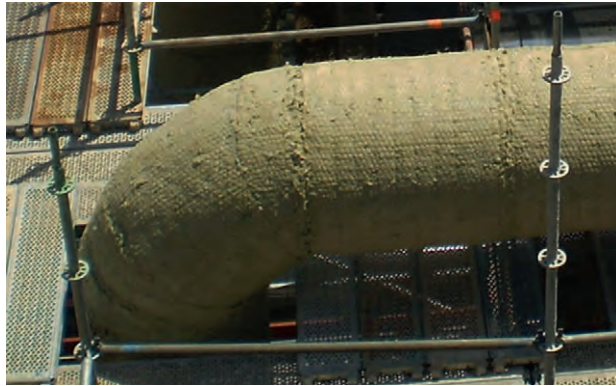
Figura 4.3.2.D. Ejemplo de cosido de manta armada.
