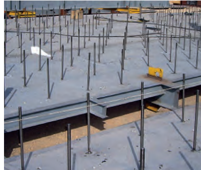
Figura 4.4.1.A. Ejemplo de colocación de pinchos y pernos.
