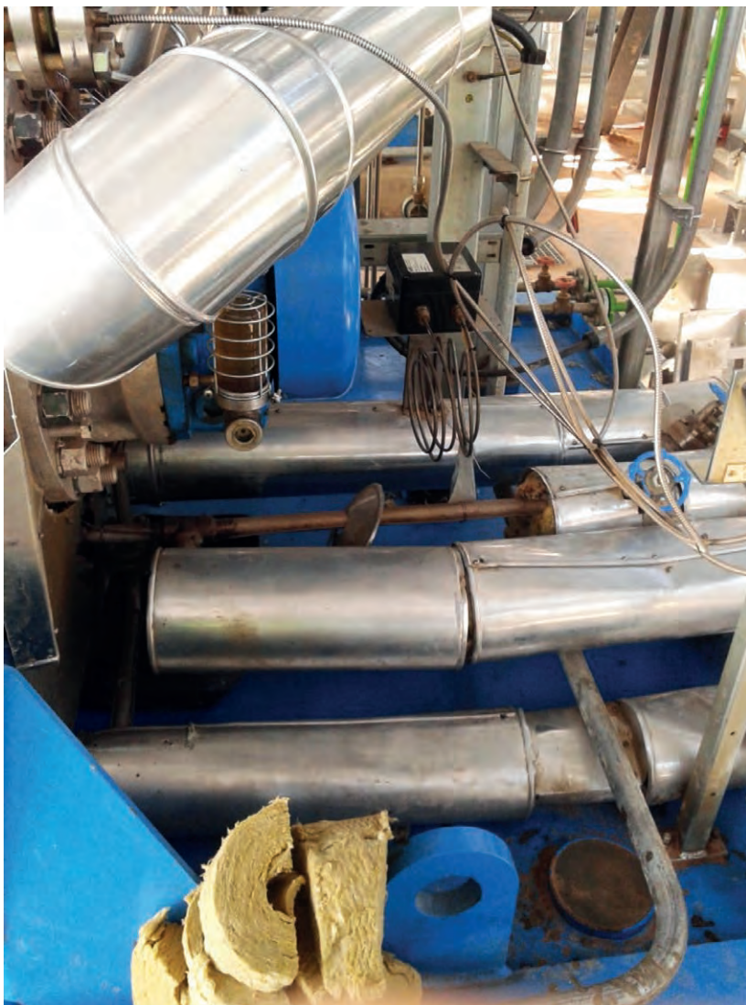
Figura 4.12.2.B. Ejemplo de aislamiento dañado en planta.
