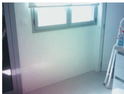
Foto 11.25 y 11.26. En la imagen visible vemos que se trata de una cocina y bajo la ventana hay azulejos. El aire que está penetrando por la mala unión de la ventana al hueco, circula por la cámara de aire y otros huecos de la fachada hasta que encuentra un punto de entrada en la vivienda, en este caso en la unión del suelo a la fachada.
