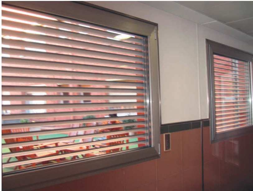
Foto 2.5. Ventanas dotadas de lamas horizontales como medio de protección solar y doble acristalamiento tradicional. La visibilidad y el aporte de luz se ven fuertemente reducidos. Fuente: Propiedad del autor.
