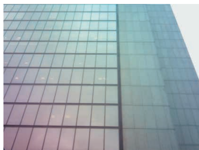
Foto 11.29 y 11.30. Se detectan dos vidrios (Ar1) con mayor transmisión de calor. Tratándose de una zona diáfana en el interior, debemos ya de continuar la inspección desde el interior para detectar el motivo de esta diferencia de temperatura.
