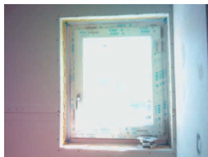
Fotos 11.3 y 11.4. Vivienda pasiva en ejecución en Rivas Vaciamadrid. Las exigencias de estanqueidad son máximas para este tipo de viviendas que no deben superar el valor n50 de 0,6 \text{ren/h} .
