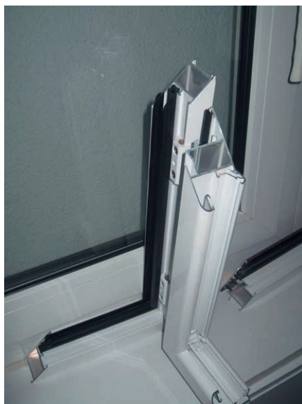
Foto 13.2. Marco metálico sin rotura de puente térmico. Fuente: Propiedad del autor.
