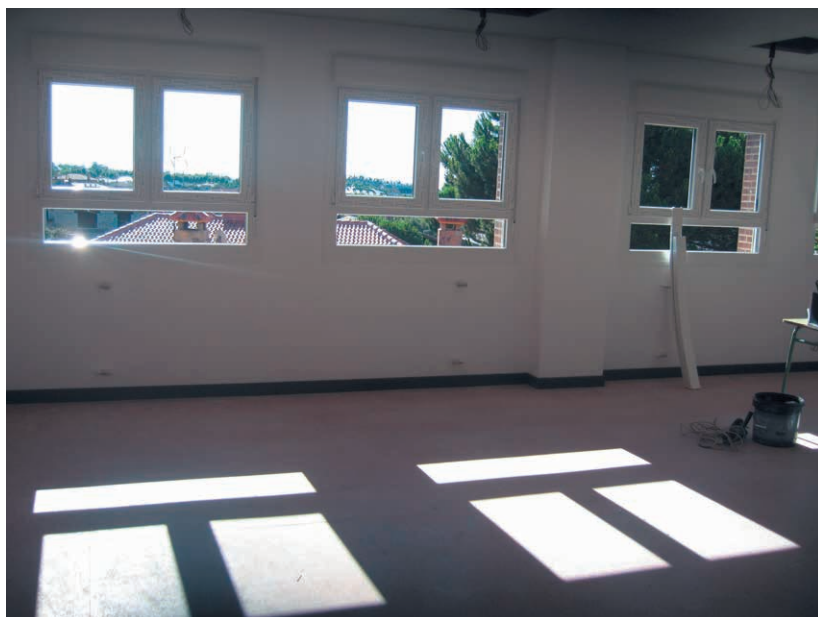
Foto 2.1. Ventanas con acristalamiento de Aislamiento Térmico Reforzado y Control Solar permitiendo visibilidad y grandes aportes de luz. SGG CLIMALIT PLUS con PLANITHERM 4S ( U=1,0 \text{ W/m}^2\text{K} ; g=0,43 ; TL=65\% ). Rehabilitación IES Diego Velázquez (Torrelodones -Madrid). Fuente: SGG CLIMALIT– Saint-Gobain Glass.
