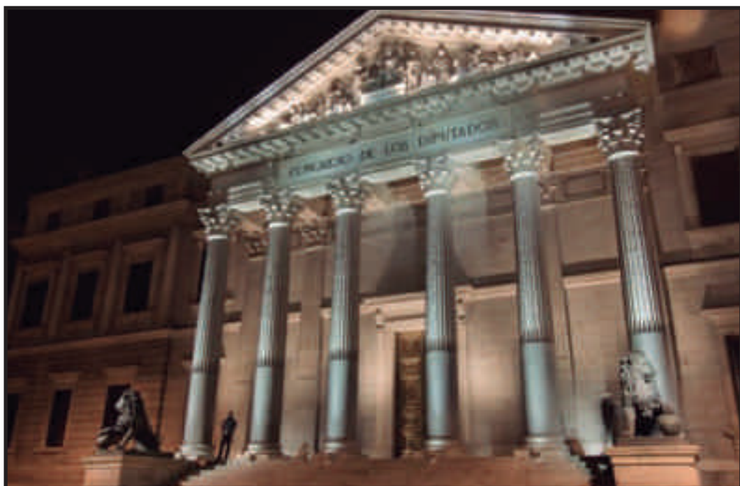
Imágenes finales de la iluminación del edificio.
