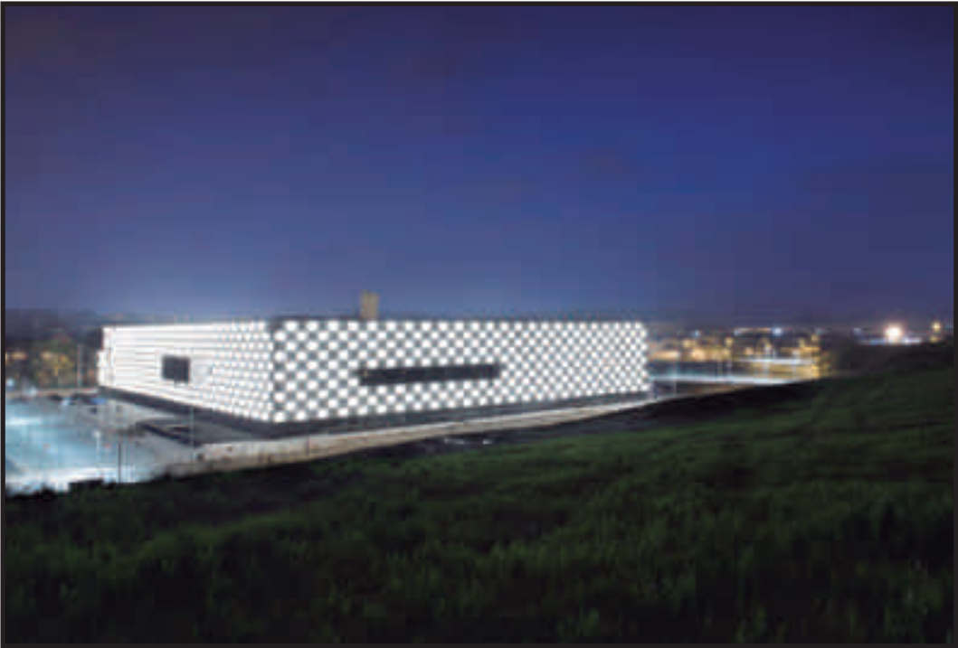
Imágenes finales de la iluminación del edificio.
