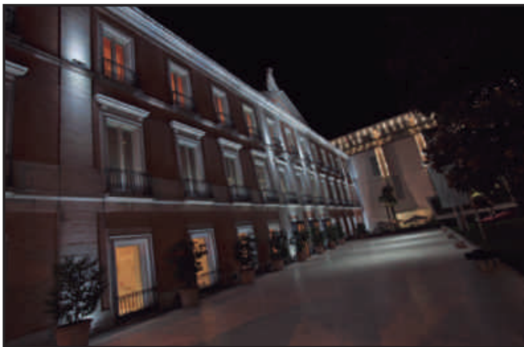
Imagen del resultado final. Las variaciones más evidentes son la temperatura de color de la fuente de luz —proyectada en 3000 K y ejecutada en 8500 K por deseo expreso del cliente—, la conexión visual del edificio con el pavimento adyacente y el realce una manera más precisa de los relieves de la fachada. En el proyecto básico se contemplaba también la reforma de la iluminación del edificio de ampliación ubicado a fondo que finalmente no se realizó.
