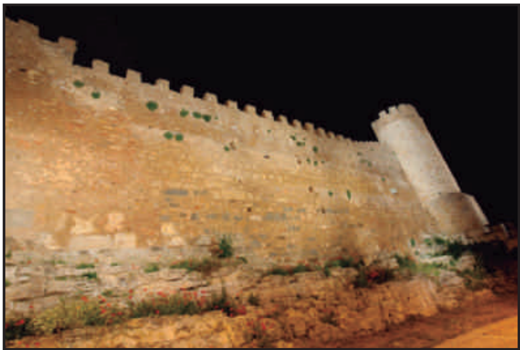
Iluminación muralla de Segovia. Intervento.
