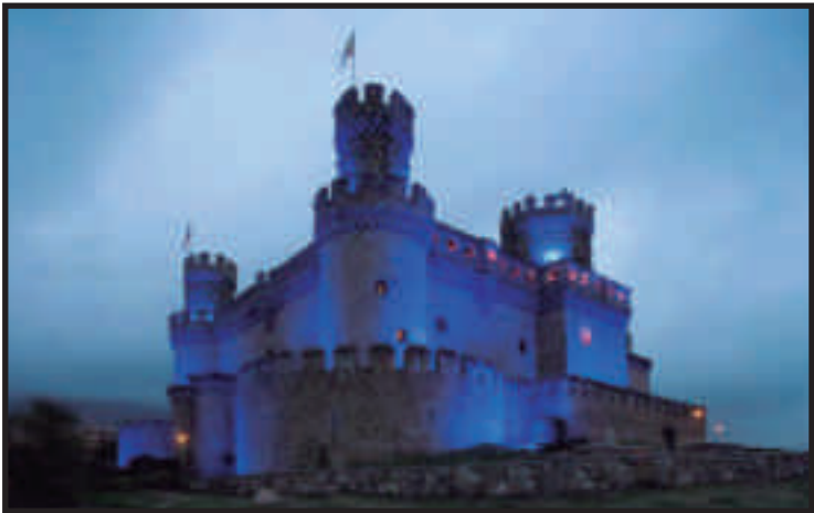
Imágenes finales de la iluminación del castillo.
