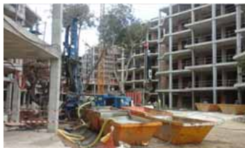
Figura 2. Perforación de 142 pozos para instalación geotérmica en un Hotel en Málaga.
