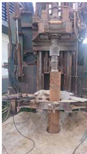
Figura 1. Perforación de pozo geotérmico de 500 m en Guadarrama.
