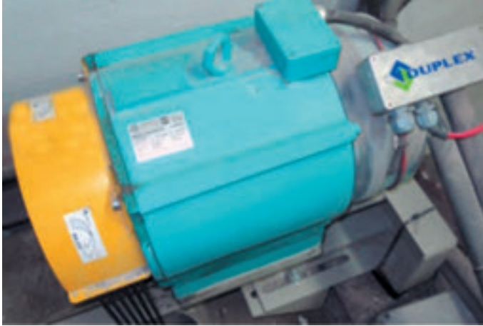
Foto 3. Máquina Gearless. Fuente: Dúplex Elevación.
