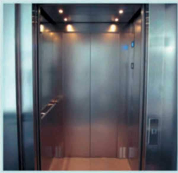
Foto 1: Cabina Iluminada con 6 Lámparas Led de 3 W.
