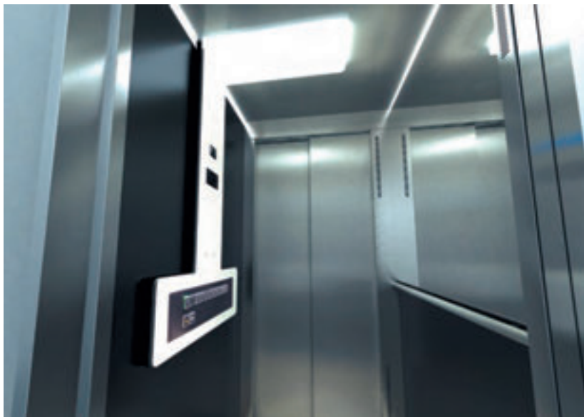
Foto 1. Ascensor accesible: pasamanos, botonera con pulsadores relieve y Braille alejados de los extremos, iluminación no deslumbrante, avisos visual y acústico. Modelo ThyssenKrupp Synergy (cabina S1).
