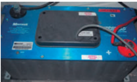
Foto 7. Detalle de la instalación del módulo de ultracapacidades. Fuente: Dúplex Elevación.
