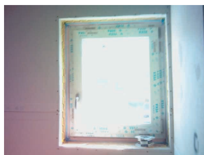
Fotos 11.3 y 11.4. Vivienda pasiva en ejecución en Rivas Vaciamadrid. Las exigencias de estanqueidad son máximas para este tipo de viviendas que no deben superar el valor n50 de 0,6 \text{ren}/\text{h} .
