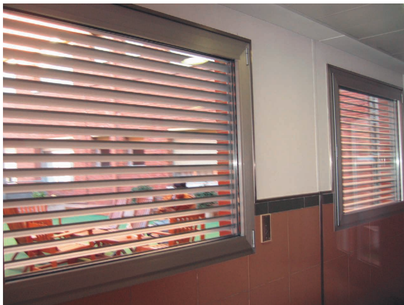
Foto 2.5. Ventanas dotadas de lamas horizontales como medio de protección solar y doble acristalamiento tradicional. La visibilidad y el aporte de luz se ven fuertemente reducidos.
