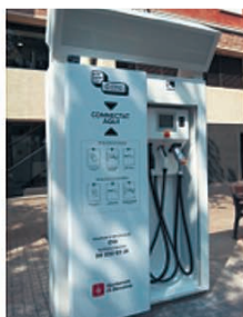
Figura 8. Equipos para la recarga rápida QPC TRI y FASTO (ENDESA).
