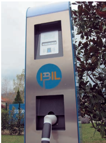
Figura 1. Terminal de carga en modo 3.
