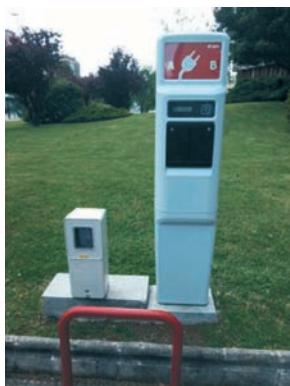
Figura 3. Postes de la serie PM&PT para exterior. Cajas Wall Box para interior.
