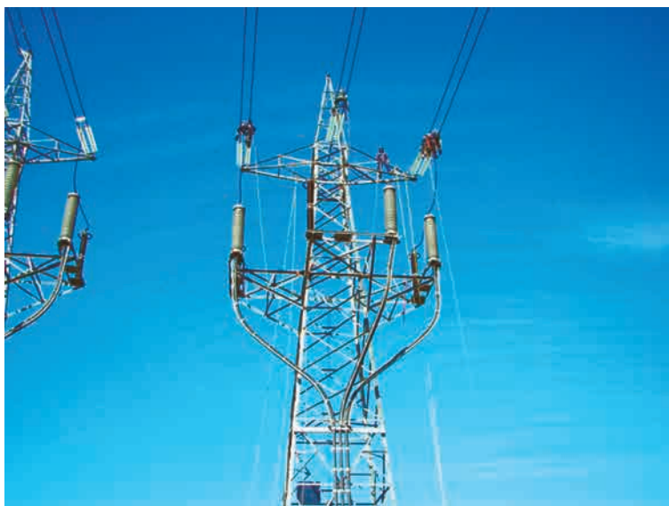
Figura 20.9. Trabajos de inspección en apoyo de 132 kV.
