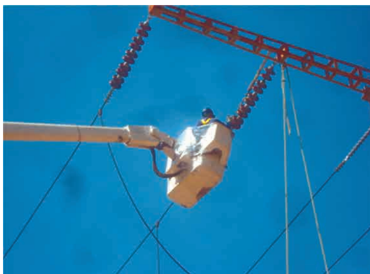
Figura 20.2. Inspección exhaustiva en una posición sin tensión.
