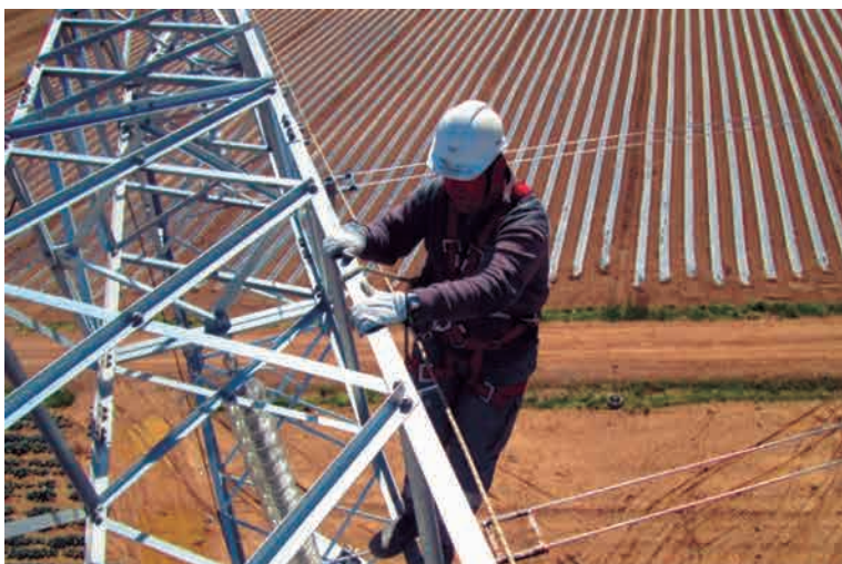
Figura 14.8. Trabajador subido a un apoyo.
