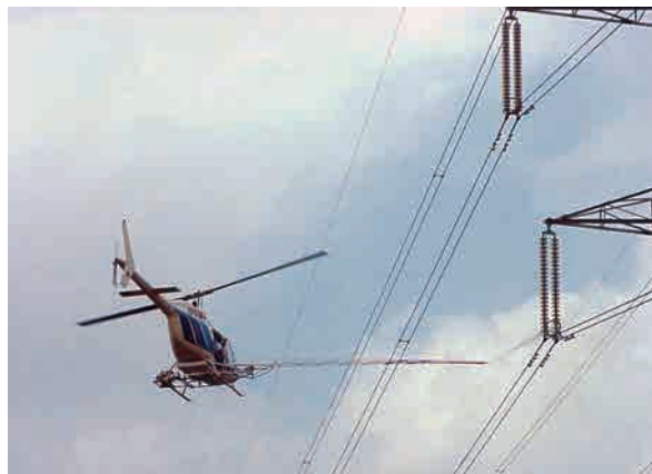
Figura 14.6. Limpieza de aisladores desde helicóptero.
