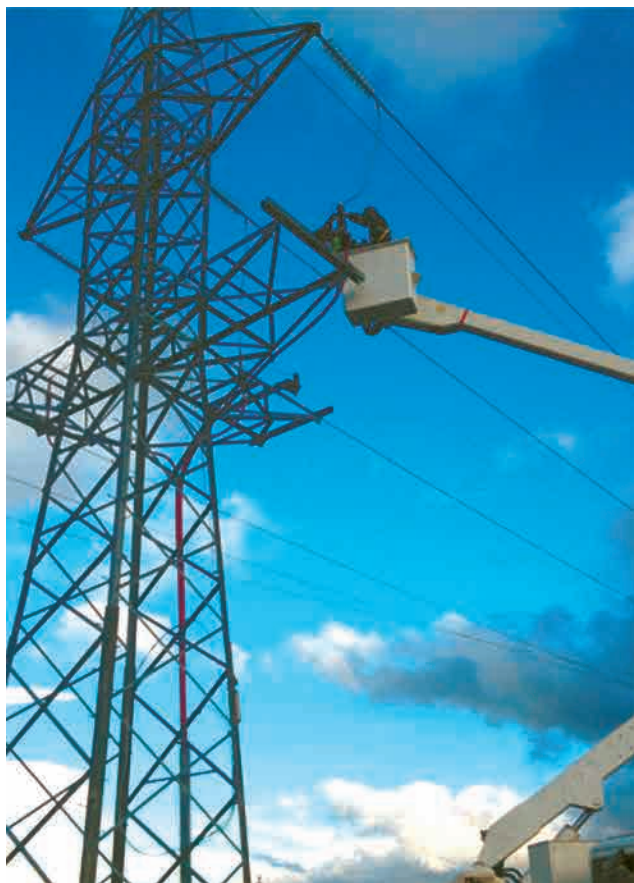
Figura 20.8. Inspección exhaustiva de un apoyo de 132 kV.
