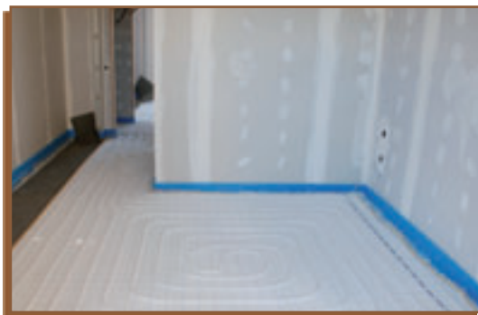
Instalación de suelo radiante
