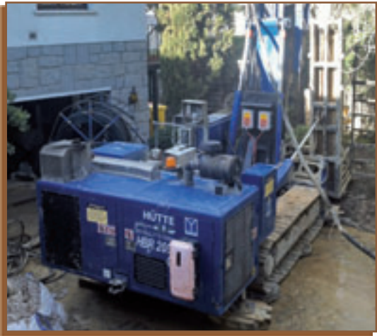
Figura 2. Labores de perforación de los sondeos geotérmicos I
