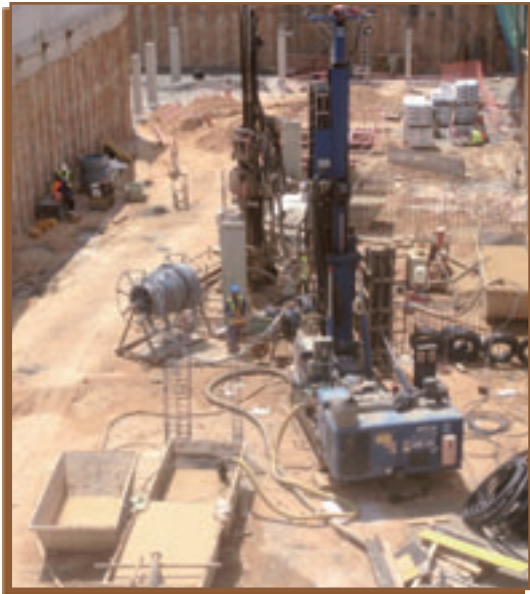
Figura 3. Labores de perforación de los sondeos geotérmicos
