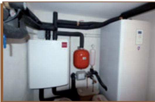
Instalación con calefacción, frío pasivo y ACS
