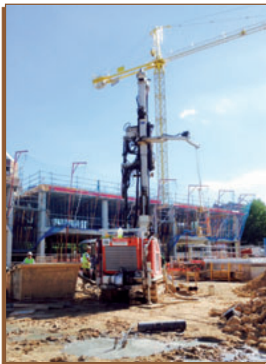
Figura 2. Labores de perforación de los sondeos geotérmicos
