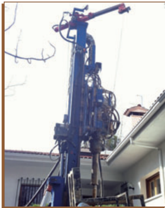
Figura 1. Labores de perforación de los sondeos geotérmicos
