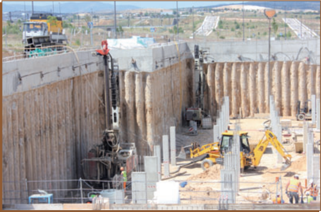
Detalle de ejecución de las perforaciones geotérmicas
