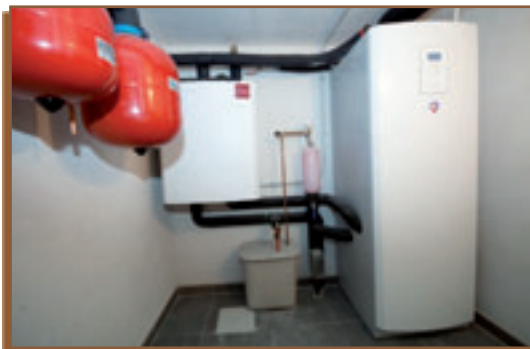
Instalación con calefacción, frío pasivo y ACS
