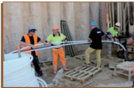
Detalle de la instalación de la sonda Geo Uponor PEX
