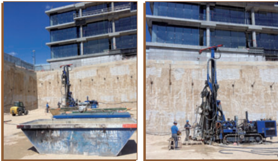
Figura 3. Labores de perforación de los sondeos geotérmicos
