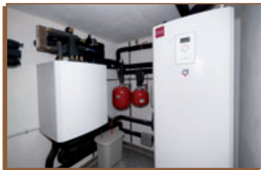
Instalación con calefacción, frío activo y ACS
