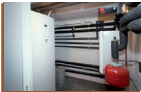
Instalación con calefacción, frío pasivo y ACS
