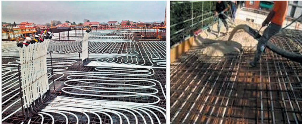
Figura 5.17. Instalación de intercambiadores y colectores de una losa termoactiva, en la fotografía se pueden apreciar los extremos cerrados con llave y manómetro de los circuitos que durante la ejecución se mantienen presurizados. Proceso de hormigonado de una losa termoactiva. Fuente: UPONOR/ENERES.
