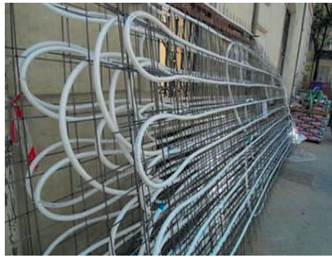
Figura 5.18. Suministro de circuitos de intercambio premontados sobre un entramado de acero que queda embebido en la losa termoactiva. Es importante señalar que el diseño de los intercambiadores permite adecuar el flujo de energía en las losas a las necesidades de equilibrio térmico de distintas partes del edificio. Fuente: UPONOR/REHAU.
