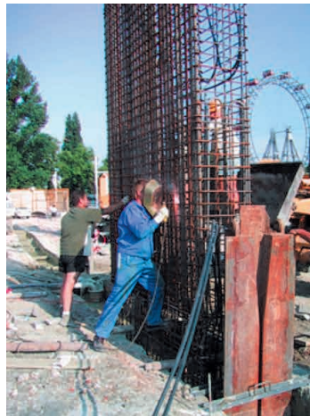
Figura 5.12. Ejecución de una pantalla termoactiva y de una solera termoactiva en las obras de ampliación del metro de la ciudad de Viena, Austria. Los rendimientos de estos elementos dependen de su superficie de intercambio con el terreno. Así, en términos generales, los pilotes tienen la misma capacidad que un muro pantalla a dos caras, un muro a una cara o una pantalla de pilotes tienen una capacidad de intercambio menor y una solera o losa con una sola cara en contacto con el terreno, aún menor. Fuente: ENERES/ENERCRET.
