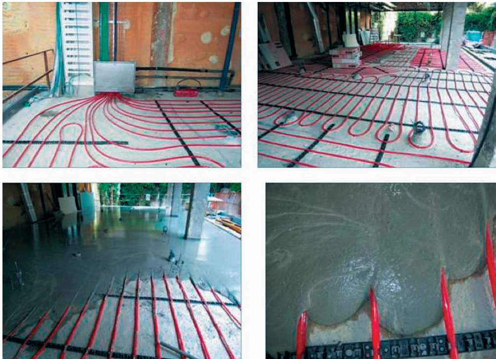
Figura 5.19. Proceso de termoactivación de un forjado en un edificio de oficinas donde la totalidad de la estructura horizontal ha sido termoactivada como sistema de climatización en interacción con estructuras geotérmicas termoactivas. Fuente: ENERES.
