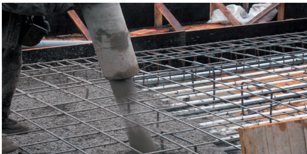
Foto 3.11. Hormigonado de un forjado con TABS en la sede de IDOM en Madrid.
