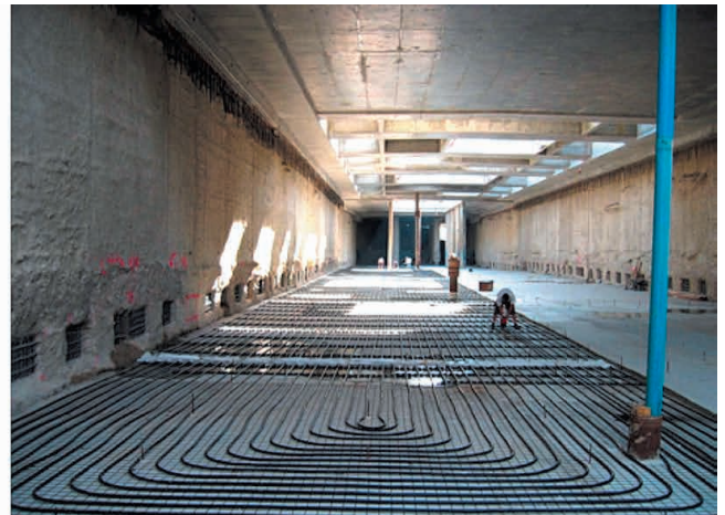
Figura 5.12. Ejecución de una pantalla termoactiva y de una solera termoactiva en las obras de ampliación del metro de la ciudad de Viena, Austria. Los rendimientos de estos elementos dependen de su superficie de intercambio con el terreno. Así, en términos generales, los pilotes tienen la misma capacidad que un muro pantalla a dos caras, un muro a una cara o una pantalla de pilotes tienen una capacidad de intercambio menor y una solera o losa con una sola cara en contacto con el terreno, aún menor. Fuente: ENERES/ENERCRET.
