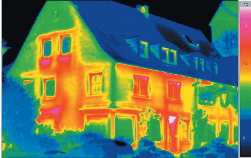
Figura 1. Pérdidas térmicas en un edificio residencial con un sistema deficiente de aislamiento. Fuente: Verband Privater Bauherren e.V./Bundesverband Deutscher Baustoff-Fachhandel e.V.
