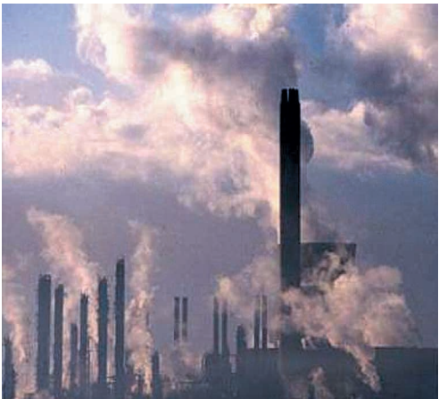
Fotografía 2. Torres de Centrales Eléctricas. Fuente: RTR Energía.
