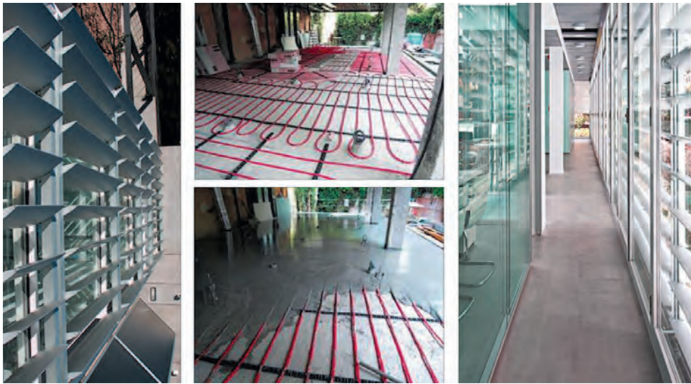
Figura 5.29. El control solar y el control de la ventilación para el refrescamiento pasivo son algunos de los factores que interactúan con el reforzado recurso inercial del edificio. Que se climatiza íntegramente con recursos geotérmicos captados por cimentaciones termoactivas y canalizados al interior del edificio a través de forjados termoactivos en la envolvente y Fuente: ENERES/IEI.
