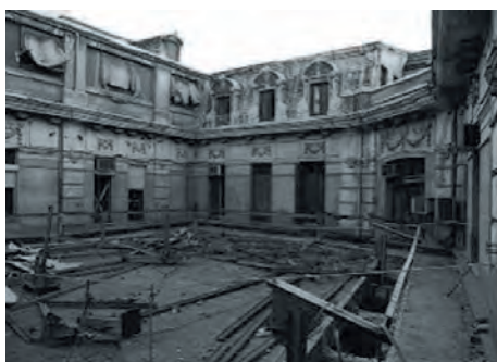
Figura 5.31. Oficinas de la Administración del Estado en un palacete protegido en el Barrio de Chamberí de Madrid. Estados previo y posterior a la rehabilitación de la envolvente exterior del edificio. Que integra sistemas de pretratamiento pasivo del aire, geotermia y estructuras termoactivas para la climatización, en un contexto de rehabilitación muy exigente.
