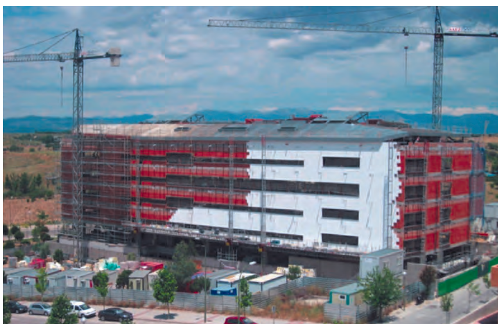
Foto 3.9. Colocación del aislamiento térmico por el exterior de la fachada de la sede de IDOM en Madrid.
