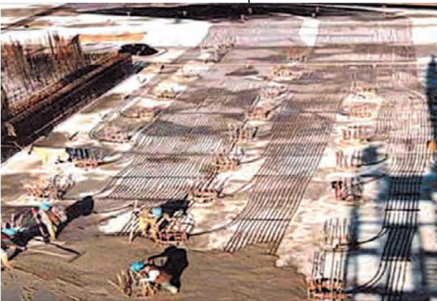
Figura 5.10. Red de tubos colectores horizontales que conectan los circuitos embebidos en las cimentaciones termoactivas con el colector general de la instalación. Fuente: ENERES/ENERCRET.
