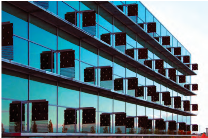
Foto 3.3. Fachada norte de la sede de IDOM en Madrid. Muro cortina con banderolas verticales que evitan deslumbramientos a última hora del día en verano.
