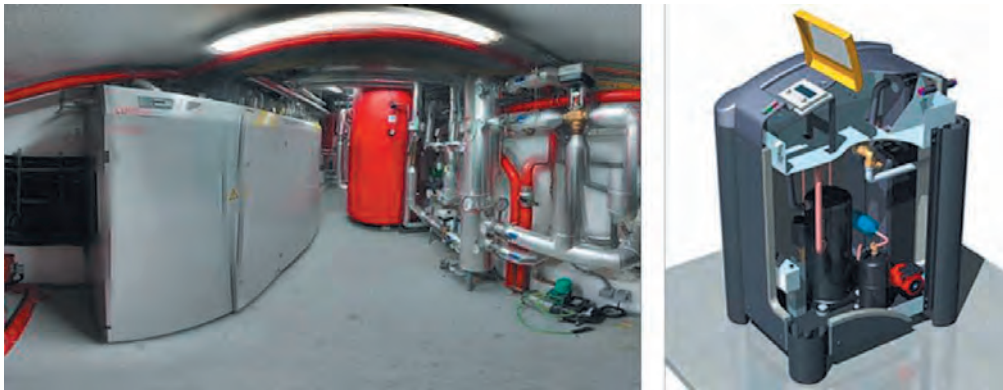
Figura 5.27. La implantación de sistemas termoactivos suele permitir recuperar una superficie útil significativa en los edificios. A la práctica desaparición, por integración, de los sistemas de transferencia de energía, se suma la reducción de los conductos y sistemas de renovación y tratamiento del aire, y la fácil implantación de las bombas de calor agua-agua. Fuente: ENERES.
