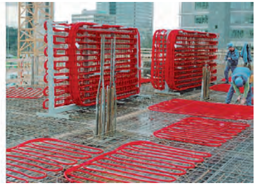
Figura 5.18. Suministro de circuitos de intercambio premontados sobre un entramado de acero que queda embebido en la losa termoactiva. Es importante señalar que el diseño de los intercambiadores permite adecuar el flujo de energía en las losas a las necesidades de equilibrio térmico de distintas partes del edificio. Fuente: UPONOR/REHAU.
