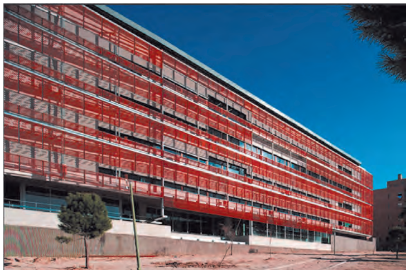
Foto 3.4. Fachada sur de la sede de IDOM en Madrid. Doble piel metálica perforada separada a más de un metro de la fachada para facilitar su ventilación natural.
