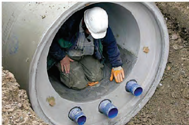
Intercambiador de energía integrado en un conducto enterrado de aguas residuales.
