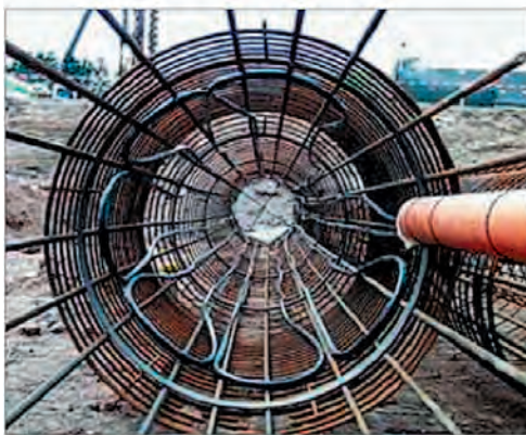
Figura 11. Pilotes termoactivos ejecutados in situ. Los pilotes se dotan de varios bucles de tubería de polietileno en circuito cerrado, atados a la armadura estructural, que se introduce en la perforación del terreno antes de rellenarla con hormigón. En el caso de terrenos inestables la perforación se rellena de hormigón para estabilizarla y la armadura y los circuitos se hincan posteriormente. La realización de este proceso requiere de una cuidadosa ejecución y también de la correcta disposición de los tubos, con radios de giro y fijaciones adecuadas. La selección del tipo de tubo, entre los muchos que hoy ofrece la industria, también está orientada a las solicitaciones y esfuerzos que supone el proceso de puesta en obra. Fuente: ENERES/ENERCRET.
