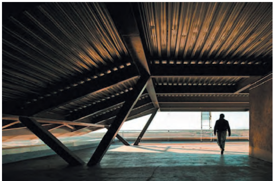
Foto 3.7. Cubierta de la sede de IDOM en Madrid. La doble piel absorbe toda la radiación solar y se encuentra perfectamente ventilada naturalmente.
