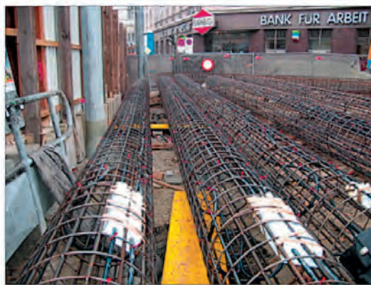
Figura 11. Pilotes termoactivos ejecutados in situ. Los pilotes se dotan de varios bucles de tubería de polietileno en circuito cerrado, atados a la armadura estructural, que se introduce en la perforación del terreno antes de rellenarla con hormigón. En el caso de terrenos inestables la perforación se rellena de hormigón para estabilizarla y la armadura y los circuitos se hincan posteriormente. La realización de este proceso requiere de una cuidadosa ejecución y también de la correcta disposición de los tubos, con radios de giro y fijaciones adecuadas. La selección del tipo de tubo, entre los muchos que hoy ofrece la industria, también está orientada a las solicitaciones y esfuerzos que supone el proceso de puesta en obra. Fuente: ENERES/ENERCRET.
