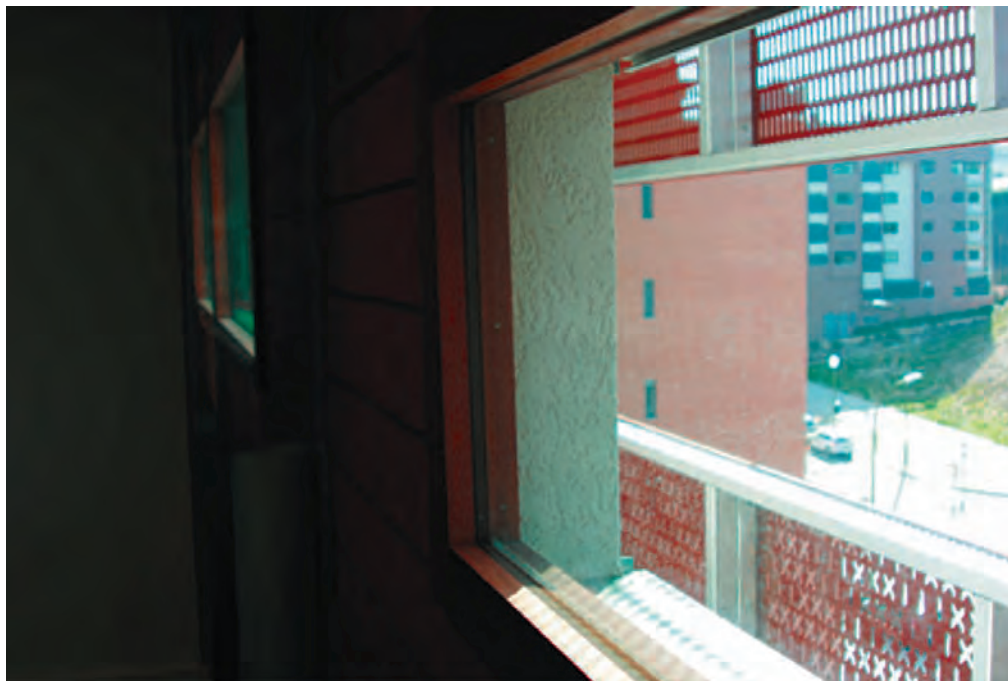
Foto 3.8. Fachada de la sede de IDOM en Madrid compuesta básicamente por dos capas: termoarcilla vista al interior y 12 cm de aislamiento.
