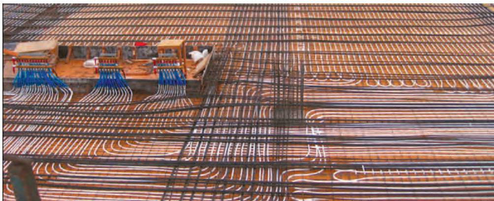
Foto 3.10. Forjado en proceso de construcción antes de la ejecución de la armadura superior del mismo y previa a su hormigonado. Las vainas negras son para el postesado de la estructura. Las tuberías de TABS son de color blanco.
