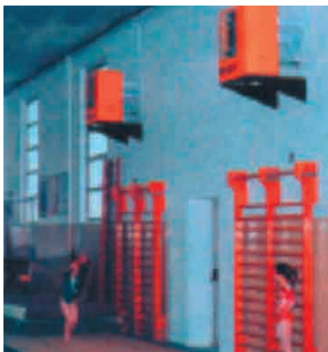
Foto 4.11. Calefacción de talleres. Aerotermos a gas natural.
