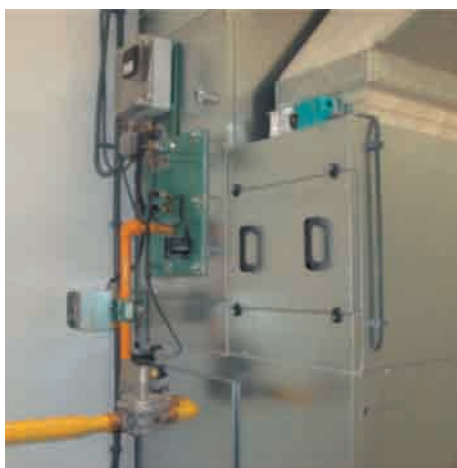
Foto 4.3. Quemador de gas natural en cabina de pintura.
