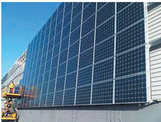
Foto 6.1. Instalación de los módulos fotovoltaicos.
