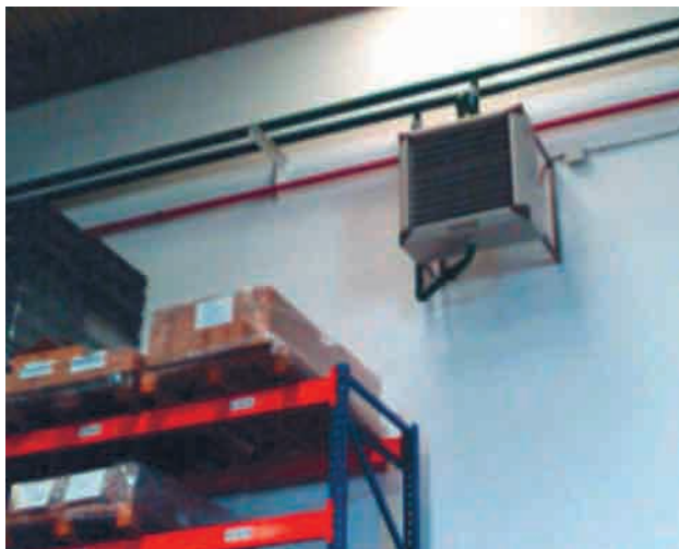
Foto 4.10. Calefacción de talleres. Aerotermos de agua caliente.
