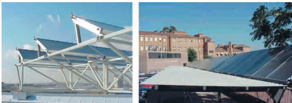
Foto 5.2. Posibilidades de montaje. Colectores planos.
