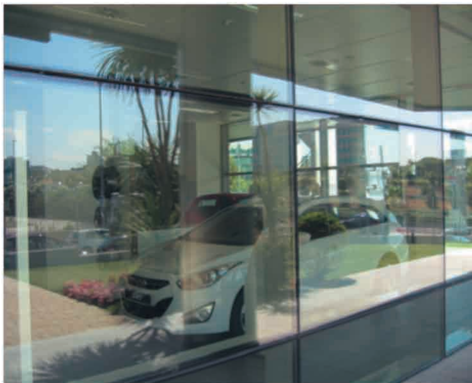
Foto 7.23. Concesionario acristalado con UVA de altas prestaciones con vidrio bajo emisivo y control solar con reflexión similar a la solución tradicional.
