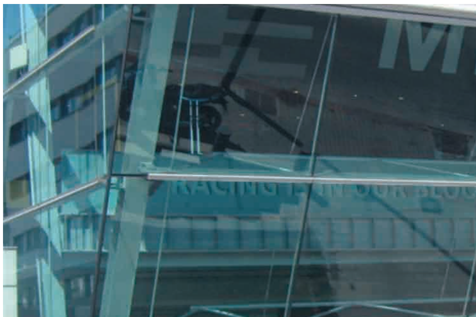
Foto 7.17. Fachada de concesionario (orientación E, 14:10 h) con vidrios laminados de control solar permitiendo ver el interior del mismo. Fuente: propiedad del autor.
