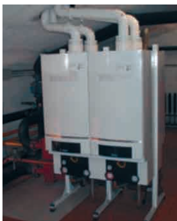
Foto 4.12. Calderas modulares a gas natural. Calefacción y ACS.
