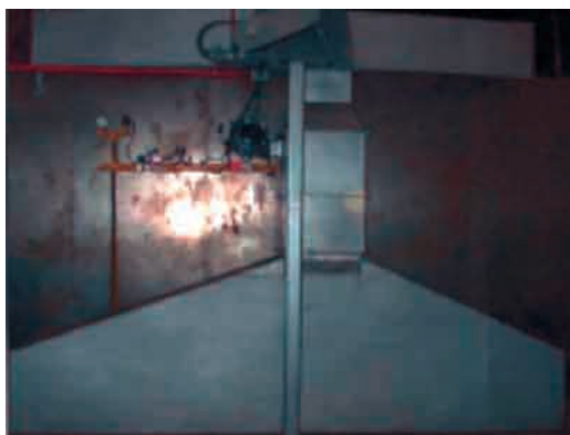
Foto 4.5. Quemador en vena de aire. Vista exterior conducto.
