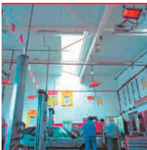
Foto 4.9. Calefacción de talleres. Placas infrarrojas.
