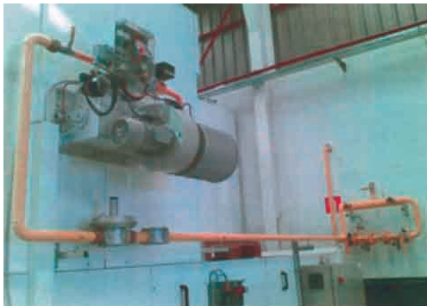
Foto 4.7. Quemador en vena de aire. Conjunto exterior (I).
