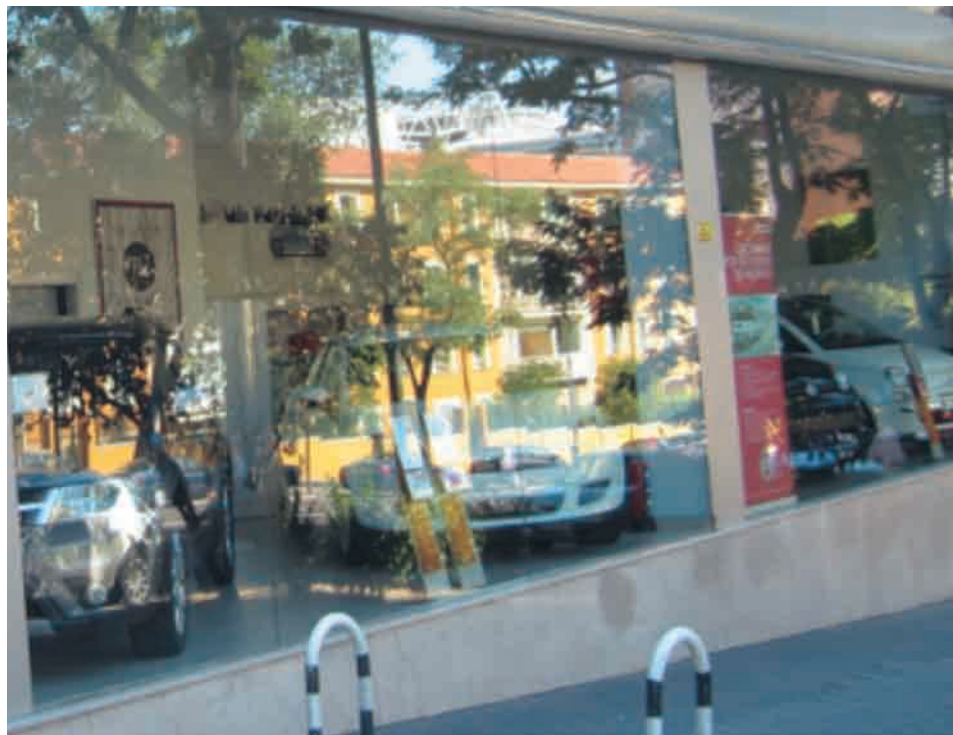
Foto 7.24. Solución convencional. Interferencias en la observación del interior debidas a altas cantidades de luz sobre un acristalamiento de reflexión moderada. Interior no visible en las condiciones de iluminación. Fuente: propiedad del autor.
