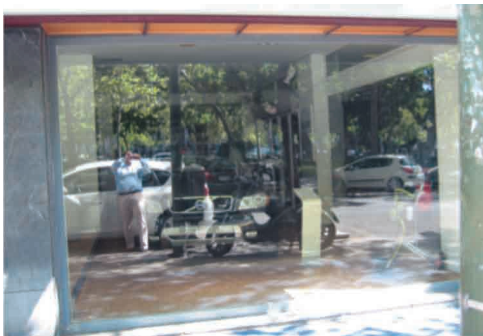
Foto 7.2. Acristalamiento tradicional orientado al oeste reflejando una gran cantidad de luz que impide la vision del interior. Fuente: propiedad del autor.
