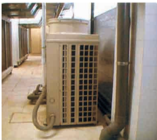
Foto 1.5. Equipo exterior de bomba de calor.
