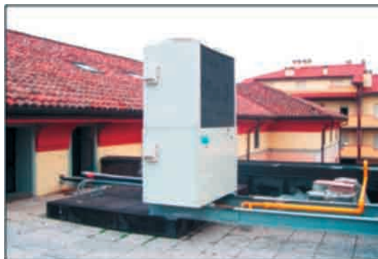
Foto 4.13. Bomba de calor a gas natural. Aire acondicionado, calefacción y ACS.
