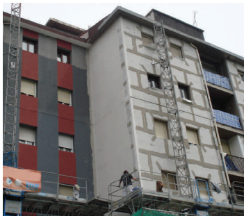
Esquema fachada Knauf Aquapanel ventilada o estanca
