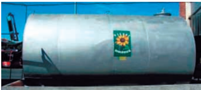
Figura 3.1. Depósito de Biodiesel para recarga de autobuses. Fuente: EMT, 2013.
