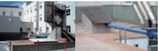
1. Cubierta del silo principal, puerta hidráulica y módulo de extracción. 2. Tubería de distribución/tornillo sin fin y entrada silo de distribución.
