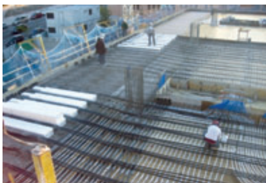
Montaje del sistema TABS
