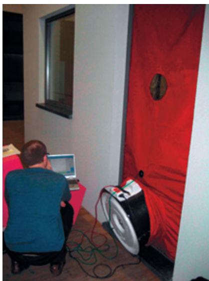
Foto 4.3. Blower Door Test.
