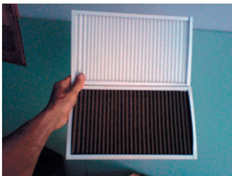
Foto 6.3. Diferencia entre filtro limpio y sucio.
