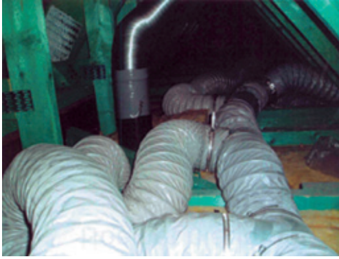
Foto 6.5. Conductos flexibles con T's y muchas curvas.
