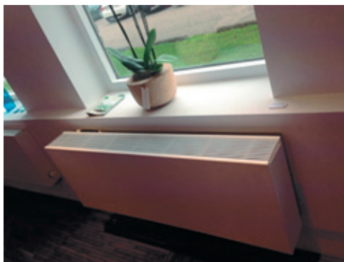
Foto 5.12. Radiador de baja temperatura o fancoil con recuperador de calor descentralizado en fachada.
