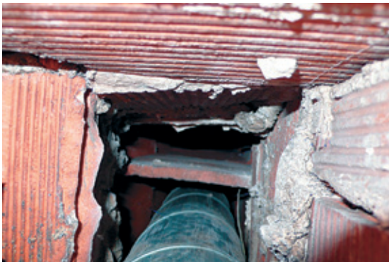
Foto 4.1. Inadecuado acabado contra el ruido de transmisión de voz.
