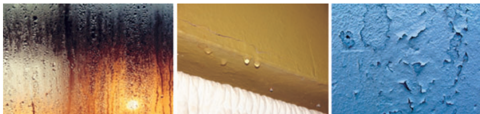
Figura 2. Condensación, humedades y desperfectos en viviendas debido a un mal aislamiento térmico.
