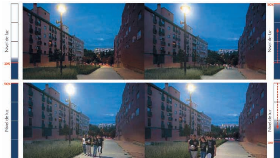
Figura 9. Lumimotion: regulación en función de la presencia de personas
