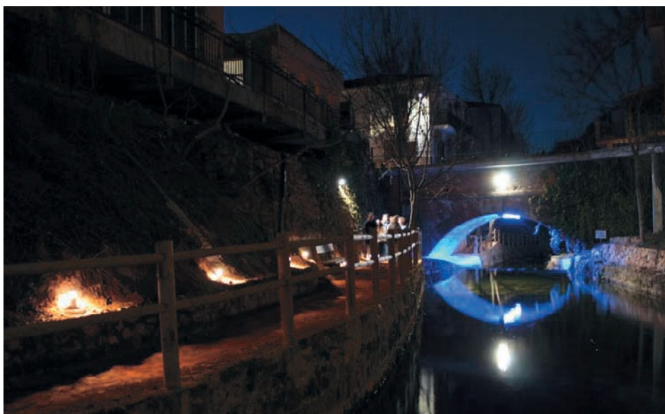
Figura 13. Nueva iluminación en los puentes
