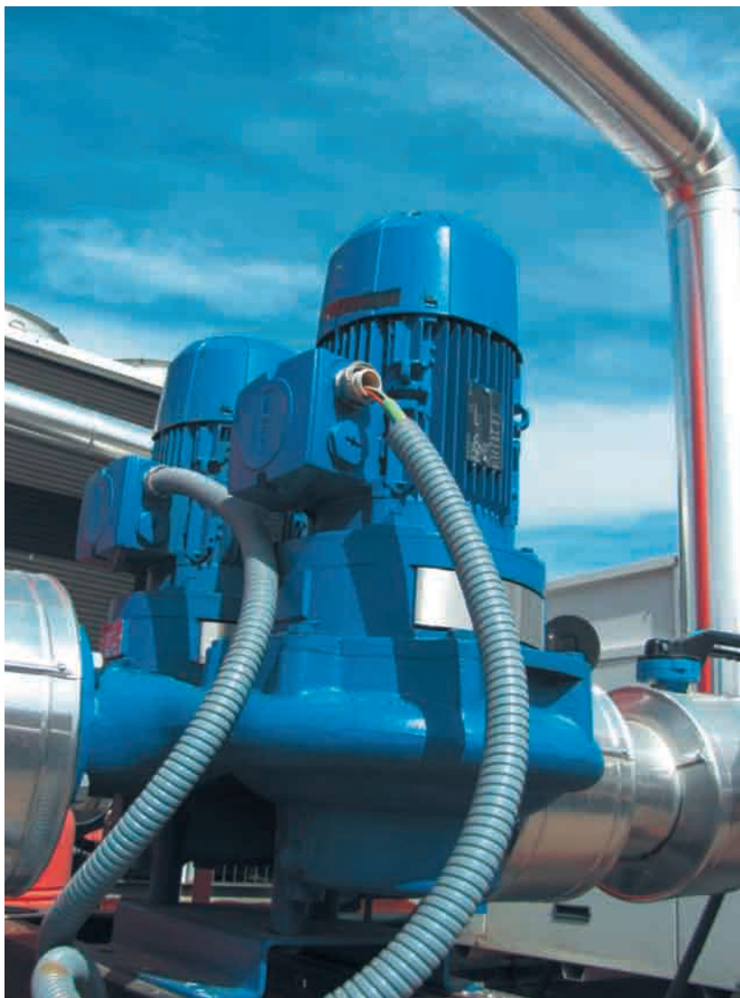
Foto 4.4. Bombas gemelas de bombeo de climatización para centro logístico de la Comunidad de Madrid. Fuente: Geoter.
