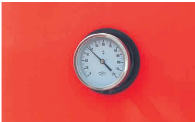
Foto A1 2. Temperatura de detalle en depósito de inercia en centro logístico de la Comunidad de Madrid. Fuente: Geoter.
