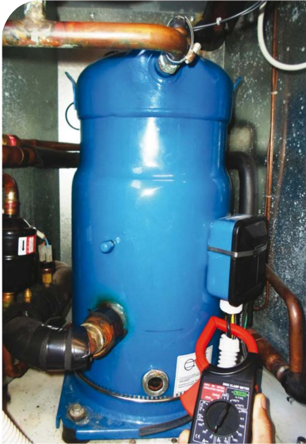
Foto 14. Medición consumo del compresor.
