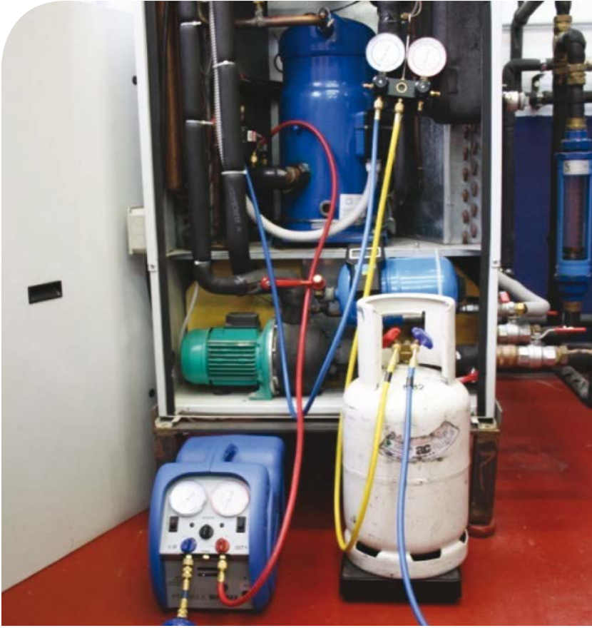
Foto 20. Recuperación de refrigerante mediante push-pull.
