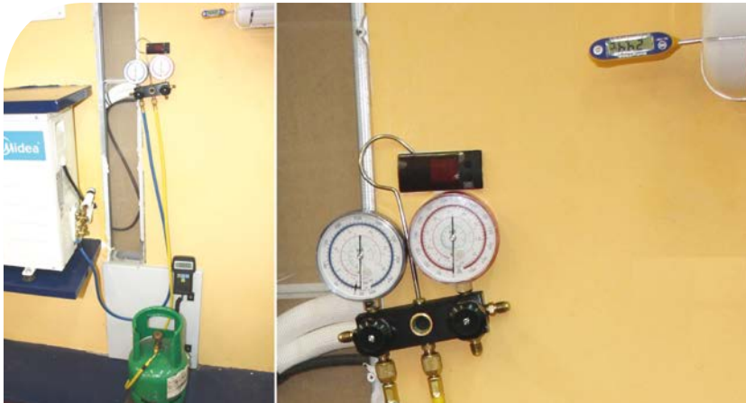
Foto 15. Método de carga por recalentamiento.
