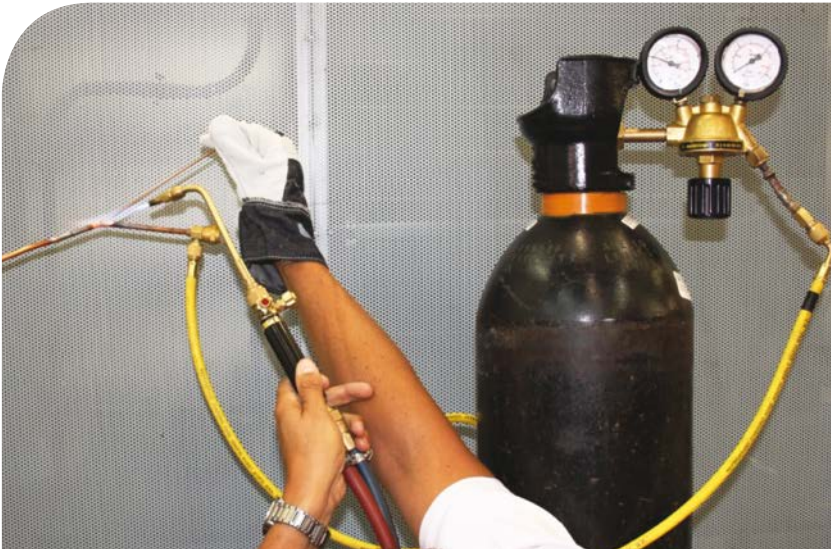
Foto 7. Soldadura en atmósfera inerte.
