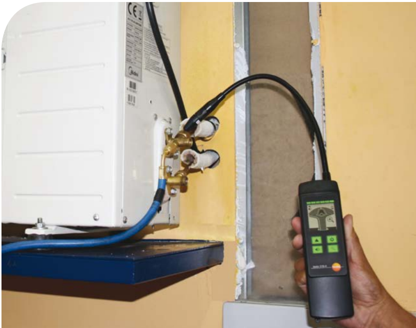
Foto 21. Método directo con detector electrónico.
