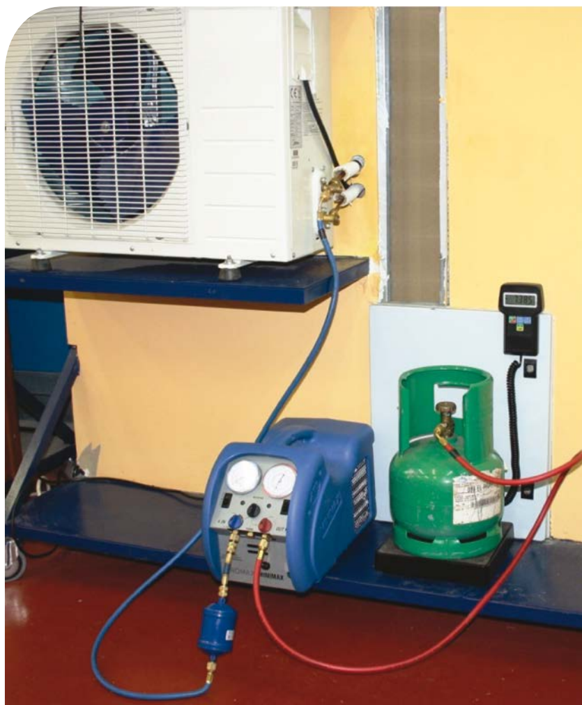
Foto 18. Recuperación de refrigerante en estado gaseoso.
