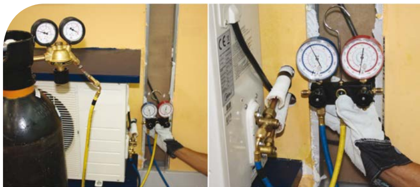
Foto 8. Prueba de estanqueidad.
