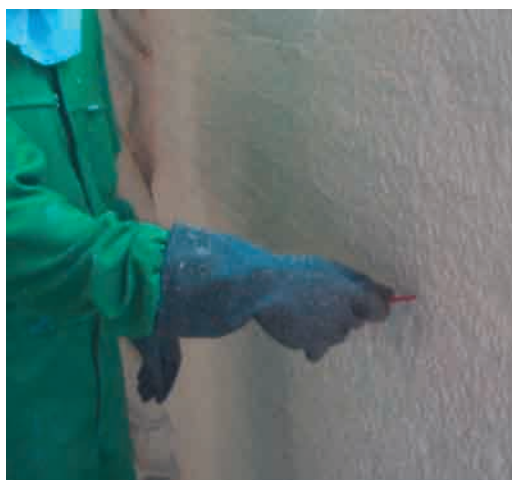
Foto 6. El ensayo de medición del espesor se realizará al menos cada 75 m 2
