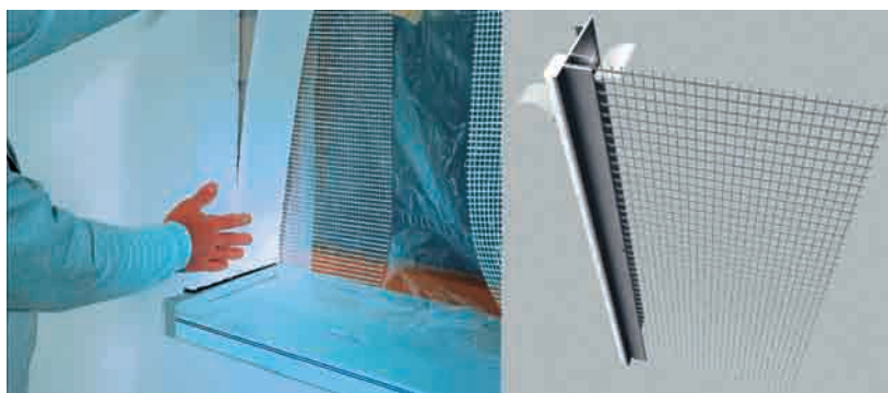
Figura 21. Instalación del aislamiento y detalle de solape de la malla de armadura en una ventana. Fuente: Guía IDAE: Sistemas de Aislamiento Térmico por el exterior (SATE) para la Rehabilitación de la Envolvente Térmica de los Edificios.
