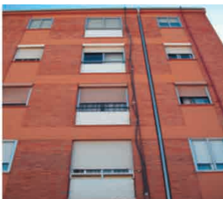
Figura 3. Fotografía de una fachada con conducciones exteriores antes de rehabilitar. Fuente: Guía IDAE: Sistemas de Aislamiento Térmico por el exterior (SATE) para la Rehabilitación de la Envolvente Térmica de los Edificios.
