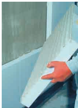
Figura 5. Detalle del pegado de una plancha de aislamiento en toda la superficie. Fuente: Guía IDAE: Sistemas de Aislamiento Térmico por el exterior (SATE) para la Rehabilitación de la Envolvente Térmica de los Edificios.
