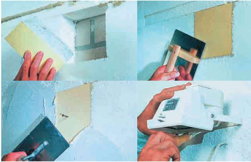
Figura 37. Instalación de un elemento de fijación para una carga pesada. Fuente: Guía IDAE: Sistemas de Aislamiento Térmico por el exterior (SATE) para la Rehabilitación de la Envoltente Térmica de los Edificios.
