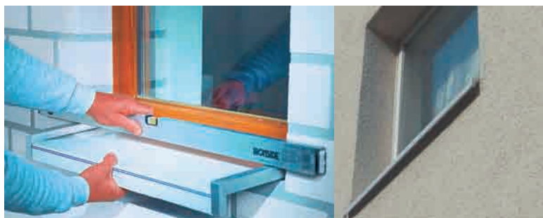
Figura 40. Detalle de un vierteaguas. Fuente: Guía IDAE: Sistemas de Aislamiento Térmico por el exterior (SATE) para la Rehabilitación de la Envolvente Térmica de los Edificios.
