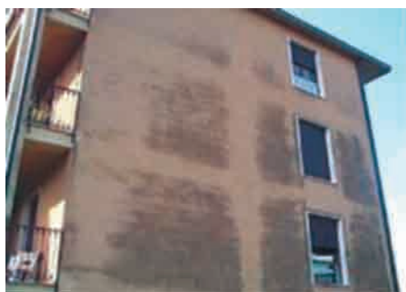
Figura 2. Edificio con defectos en los pilares y frentes de forjado. Fuente: Guía IDAE: Sistemas de Aislamiento Térmico por el exterior (SATE) para la Rehabilitación de la Envolvente Térmica de los Edificios.
