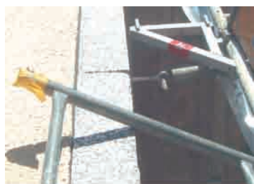
Figura 41. Detalle de la fijación del andamio a la fachada. Fuente: Guía IDAE: Sistemas de Aislamiento Térmico por el exterior (SATE) para la Rehabilitación de la Envoltura Térmica de los Edificios.
