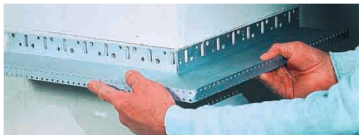
Figura 33. Detalle del perfil de arranque en una arista del edificio. Fuente: Guía IDAE: Sistemas de Aislamiento Térmico por el exterior (SATE) para la Rehabilitación de la Envolvente Térmica de los Edificios.
