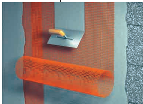
Figura 23. Dibujo donde se muestra la correcta instalación de la capa de acabado. Fuente: Guía IDAE: Sistemas de Aislamiento Térmico por el exterior (SATE) para la Rehabilitación de la Envolvente Térmica de los Edificios.
