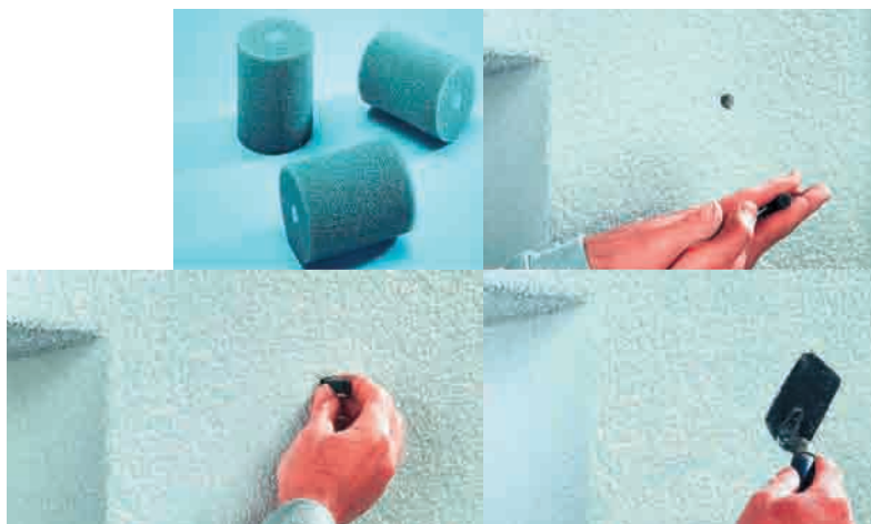
Figura 39. Detalle de una tapa de anclaje de andamio y su correcta instalación. Fuente: Guía IDAE: Sistemas de Aislamiento Térmico por el exterior (SATE) para la Rehabilitación de la Envolvente Térmica de los Edificios.
