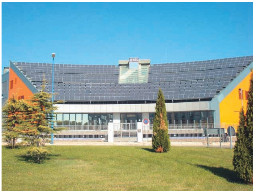
Foto 1. Ejemplo de cubierta fotovoltaica inclinada. Fuente: Abaco Ambiental
