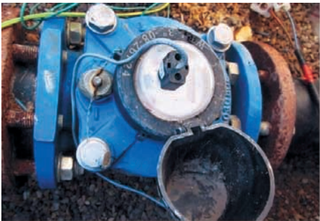
CONTADOR TIPO WOLTMAN CON EMISOR DE PULSOS CADA 100 LITROS
