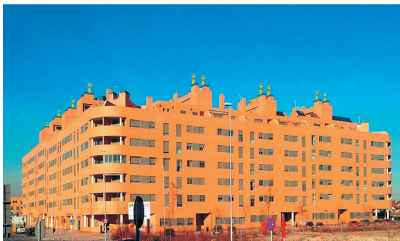
Figura 5. Imagen virtual de edificio de viviendas con extractores eólicos instalados. Fuente: F.J. España Moscoso
