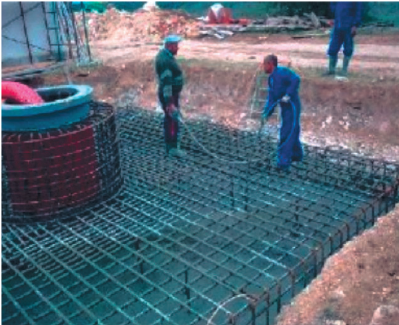
Figura 11. Cimentación. Fuente: Electricia.
