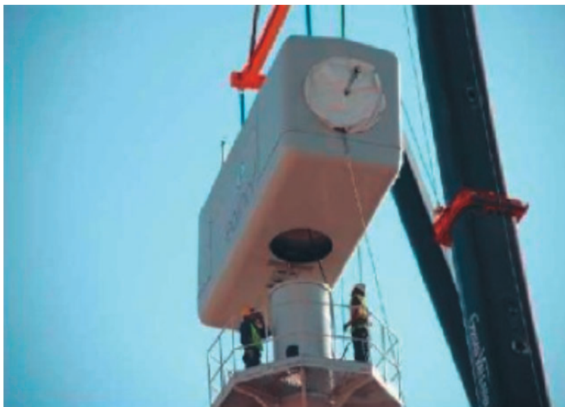
Figura 14. Montaje. Fuente: Electricia.
