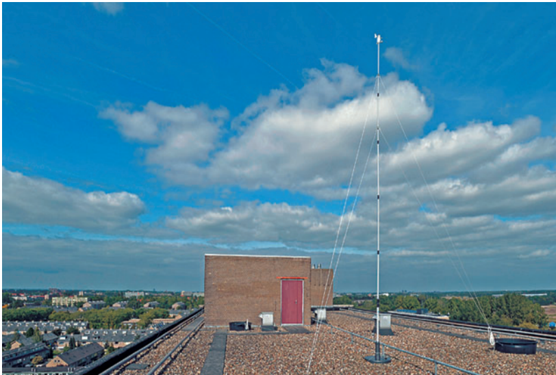
Figura 2. Torre anemométrica instalada en techo de edificio. Fuente: CIEMAT.
