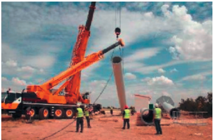
Figura 13. Montaje. Fuente: Electricia.
