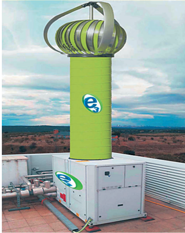
Figura 4. Sistema de ventilación con extractor eólico. fuente: F.J. España Moscoso
