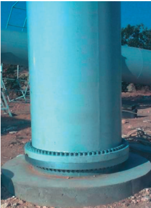
Figura 7. Unión del tramo inferior de torre a la virola de la cimentación. Verificación de pares de apriete. Fuente: Electrica Wind, S.L.
