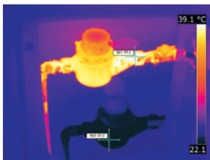
Imagen 13. En los contadores de las viviendas se encuentra sin aislar el del agua ca-liente, con un importante efecto radiador de calor.
