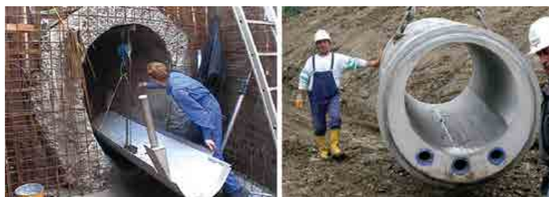
Figura 13. Ejecución de las obras de instalación de intercambiadores: instalado en un colector ovoide existente, e integrado en el hormigón un conducto de sección circular en una nueva construcción. Fuente: ENERES/KASAG.
