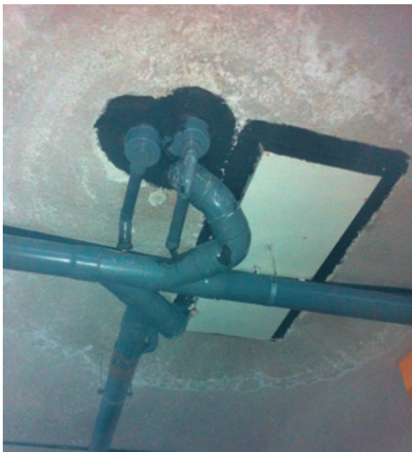
Imagen 1. Imagen visible de una bajante.
