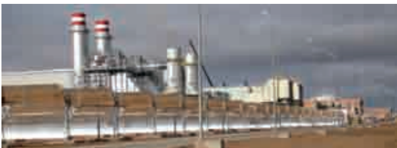
Foto 13. Central ISCC. Fuente: Archivo RENOVETEC.
