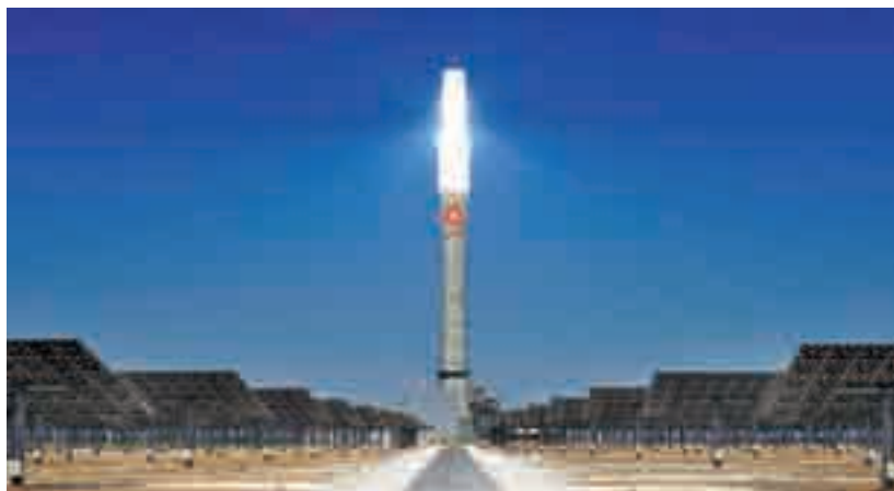
Foto 5. Vista del receptor central en operación.
