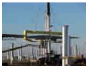
Foto 11. Montaje de heliostatos en el campo solar.
