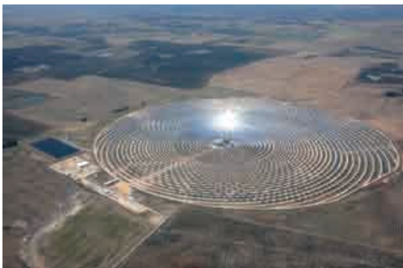
Foto 1. Vista aérea de Gemasolar.
