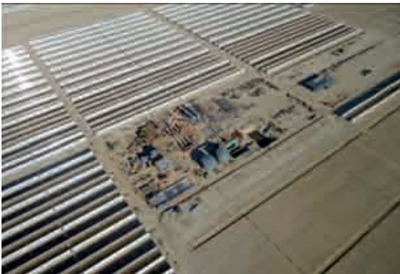
Foto 5. Instalación de Equipos Principales Aste 1A. Julio 2011.
