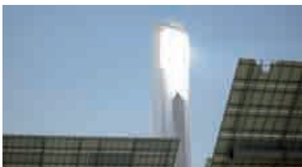
Foto 10. Receptor de cavidad. Fuente: www.centralestermosolares.com
