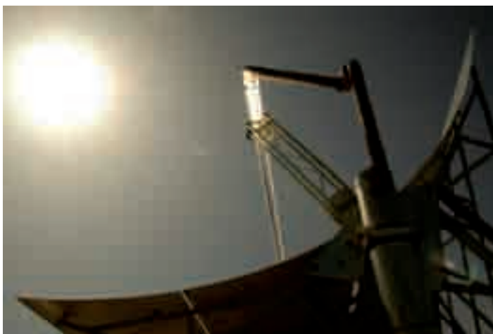
Foto 3. Colector cilindro parabólico en funcionamiento.
