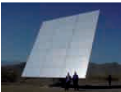
Foto 5. Heliostato Sanlúcar 90, de 21 facetas (3x7).
