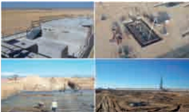
Foto 4. Cimentaciones CCP. De izquierda a derecha: cimentaciones turbina, edificio eléctrico, tanques HTF y pilotes campo solar.
