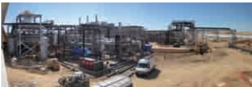
Foto 6. Montaje Tuberías Bloque de Potencia Astexol 2. Agosto 2011.
