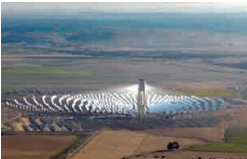
Foto 23. Vista aérea de PS10 en operación solar.
