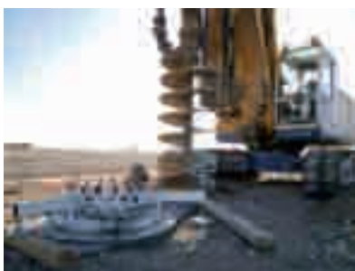
Foto 9. Ejecución de las torres de alta tensión.
