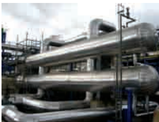
Foto 3. Intercambiadores del tren de generación de vapor. Fuente: Archivo Renovetec.
