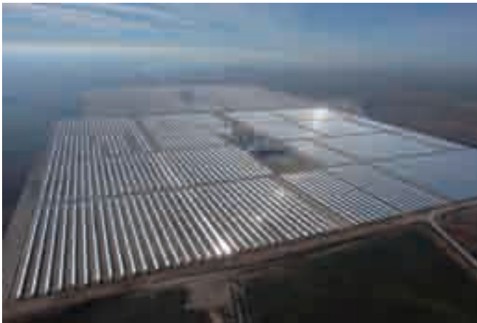
Foto 4. Foto aérea del campo solar planta Andasol.
