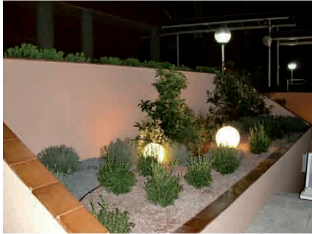
Foto 2.8. Detalle de alumbrado exterior en urbanización en la zona del Pasillo Verde de la ciudad de Madrid.
