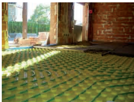
Foto A1.2. Montaje de suelo radiante en el sector residencial.
