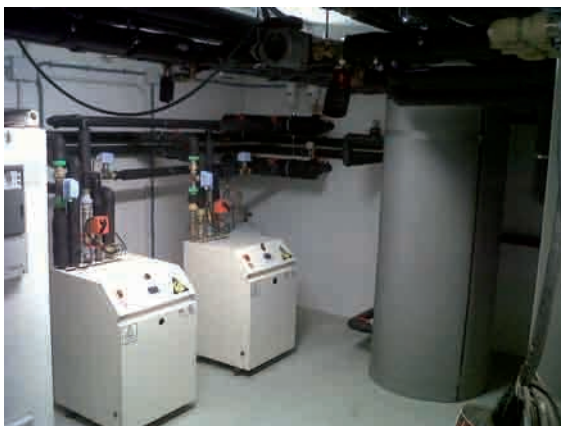
Foto A2.4. Instalación de sala técnica realizada por la empresa Clysema.
