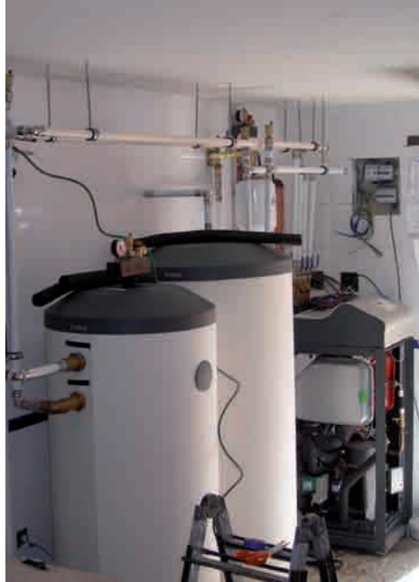
Foto A2.7. Instalación de bomba de calor geotérmica para vivienda adosada en urbanización.
