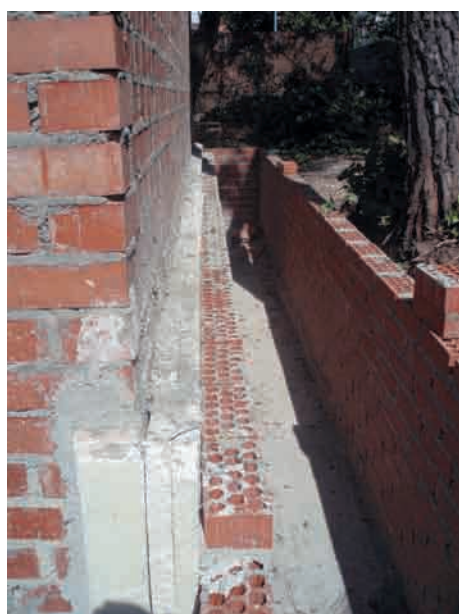
Foto A2.2. Aislamiento en la fase de construcción de una vivienda unifamiliar.
