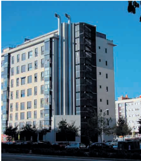
Foto 5.3. Chimeneas en comunidad de reciente construcción en el PAU de Vallecas.
