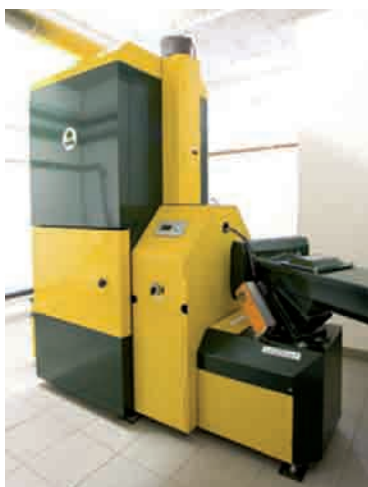
Foto A1.9. Caldera de biomasa de la firma KWB.
