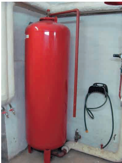
Foto 5.2. Vaso de expansión en instalación centralizada en Alcobendas.
