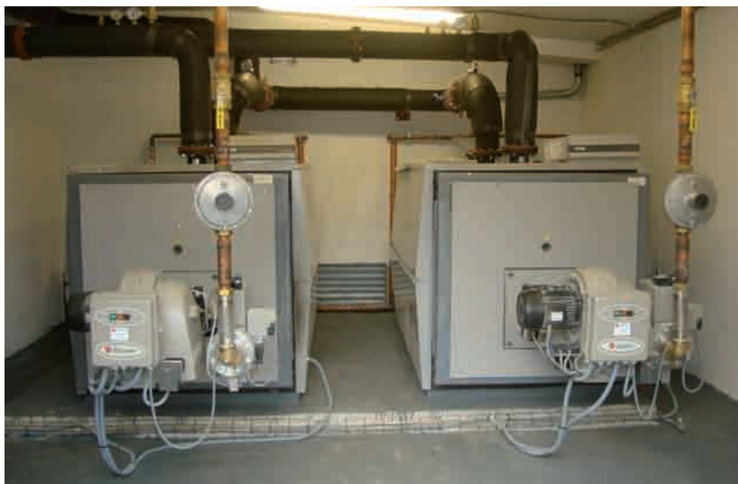
Foto A1.1. Grupo de calderas para instalaciones de altas potencias. (Fuente: Ferrolí).
