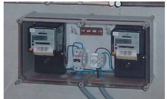
Figura 7.7. Fotografía de vatímetro fijo para cuadro (izquierda) y contador eléctrico (derecha).
