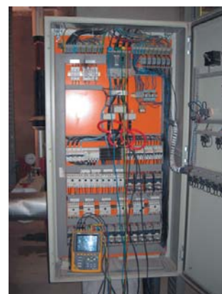
Figura 7.5. Conexión de analizador de redes eléctricas a interruptor general del cuadro.
