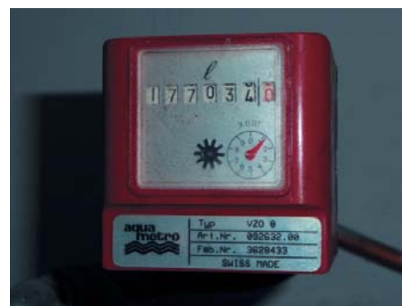
Figura 7.9. Fotografía de contador de gasóleo C.
