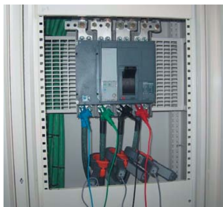
Figura 7.5. Conexión de analizador de redes eléctricas a interruptor general del cuadro.
