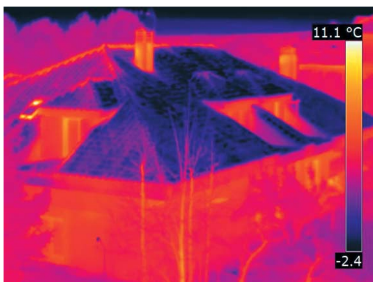
Figura 12. Imagen infrarroja del exterior de una vivienda.
