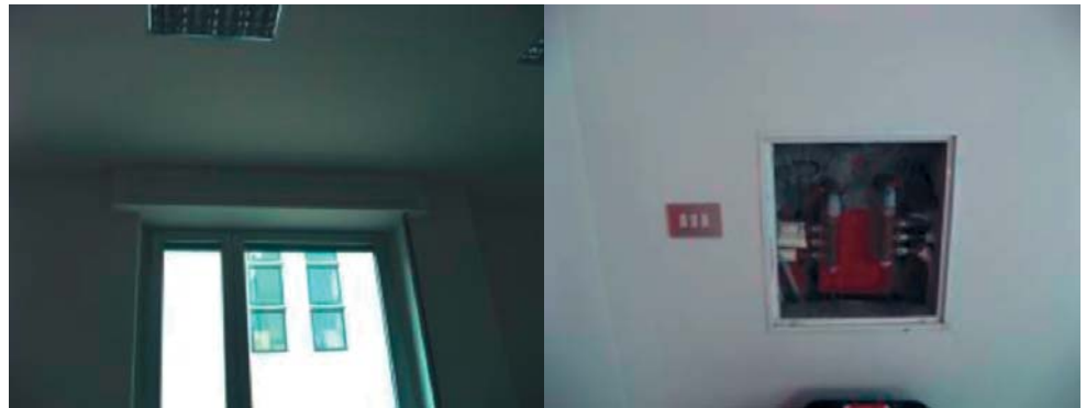
Fotografía 5. Ventana con caja de persiana.
