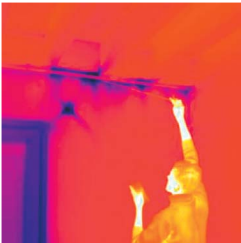
Estructural. Esto es un fallo de diseño, de fabricación o de construcción. La reparación, una vez la construcción se ha finalizado, es prácticamente imposible.
