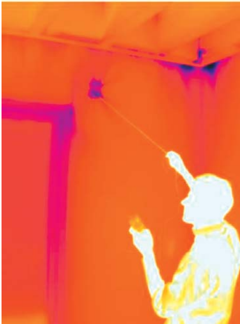
Caja de conexiones eléctricas. Error de construcción.
