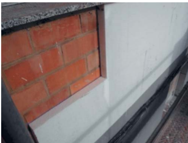
Fotografía 4. Placas de poliestireno expandido colocadas sobre la fachada original.
