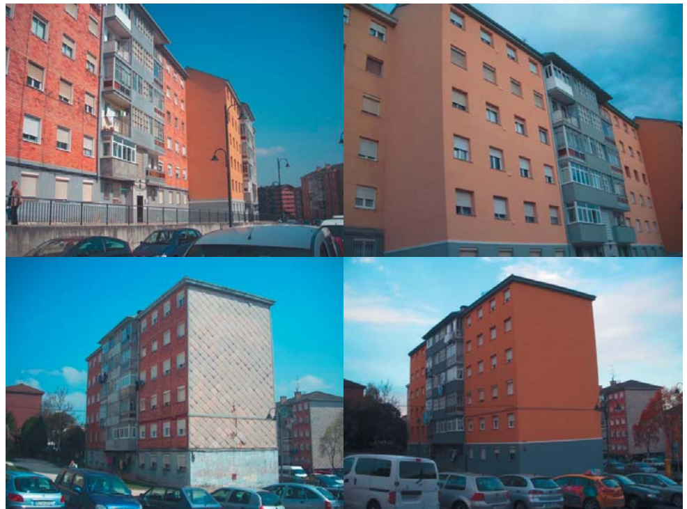
Fotografías 7. Fotografías del antes y después de algunos de los edificios rehabilitados con Rhonatherm.
