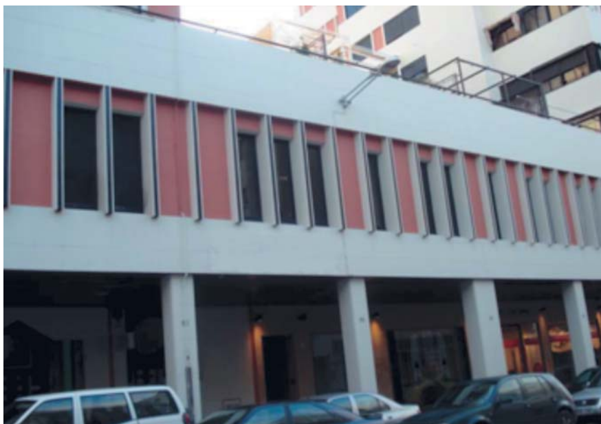
Fotografía 1. Fachada principal del edificio.
