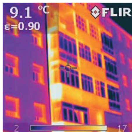
Figura 2. Edificio parcialmente aislado.
