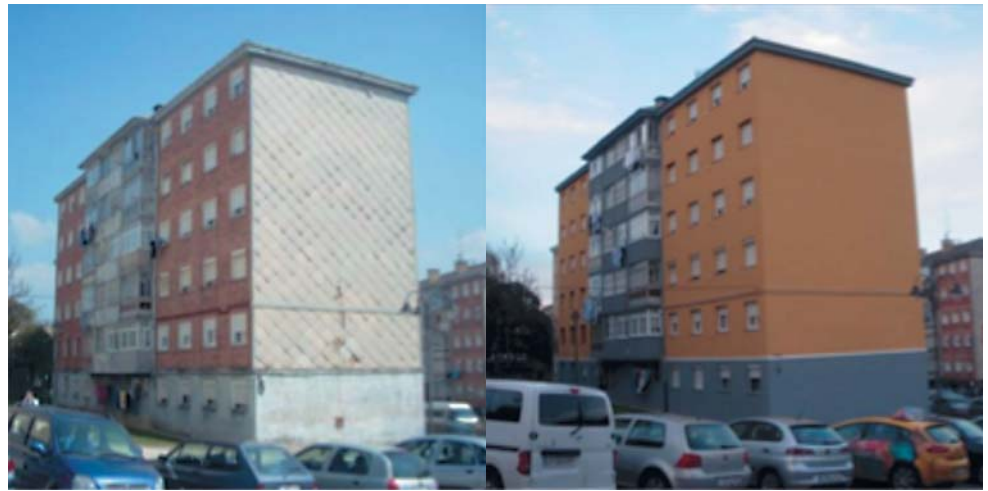
Fotografía 2. Antes y después de la rehabilitación térmica.
